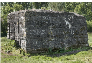
Vue de trois-quarts vers le sud-est Phot. Jean-Marc Ramette IVR31_20145905356NUCA
