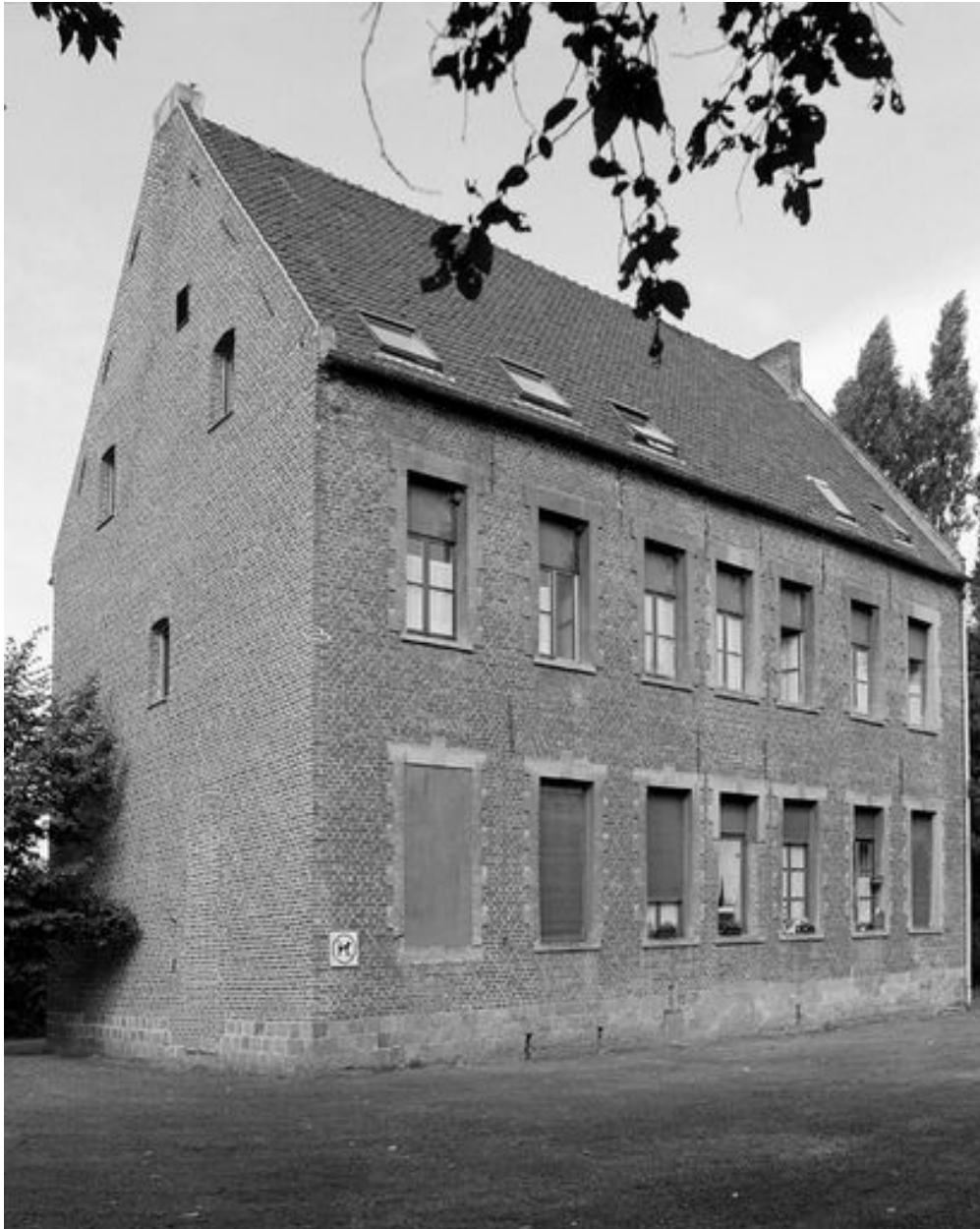
Vue générale de trois quarts de l'élévation postérieure.
