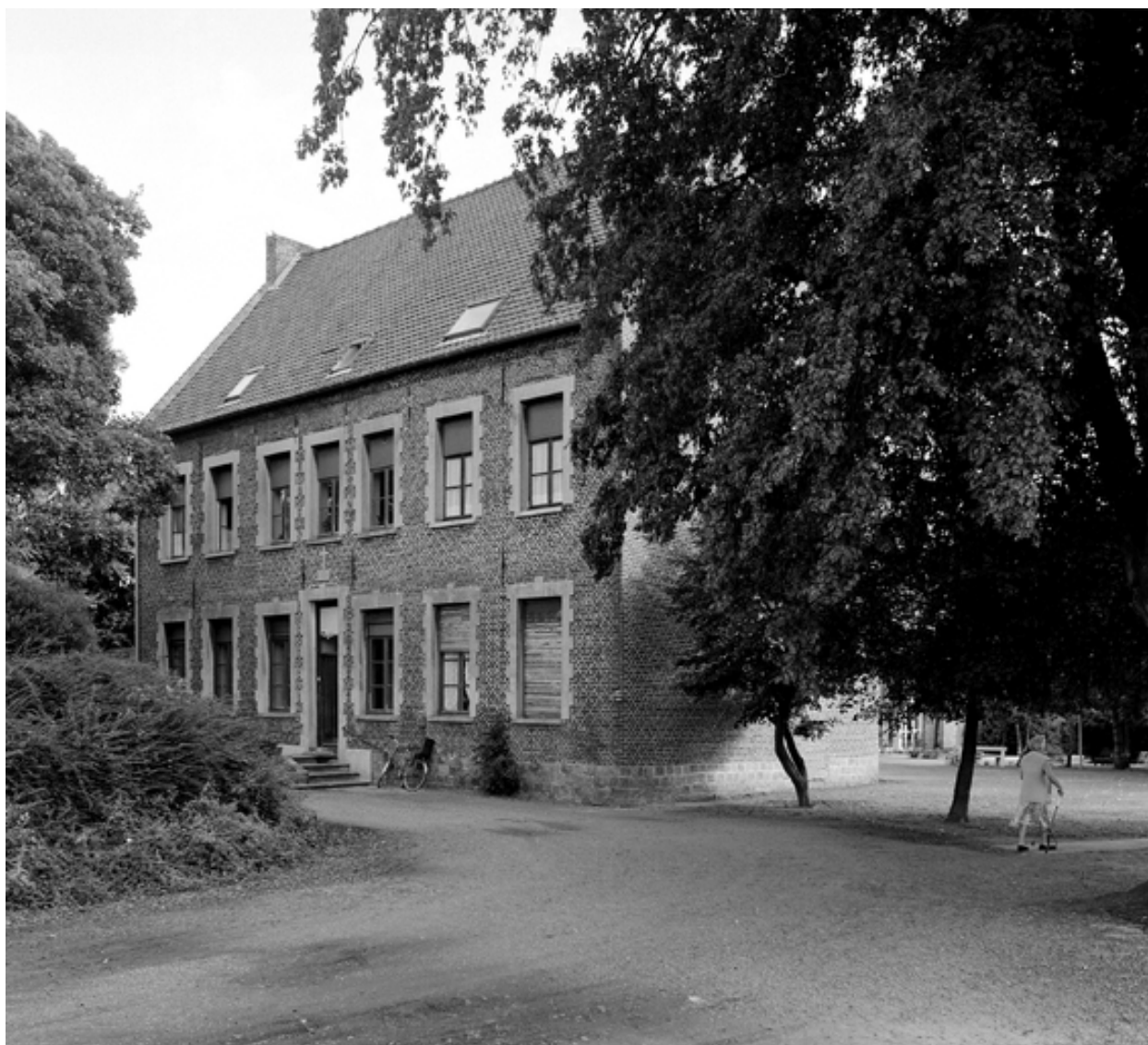
Vue générale de trois quarts de l'élévation antérieure.
