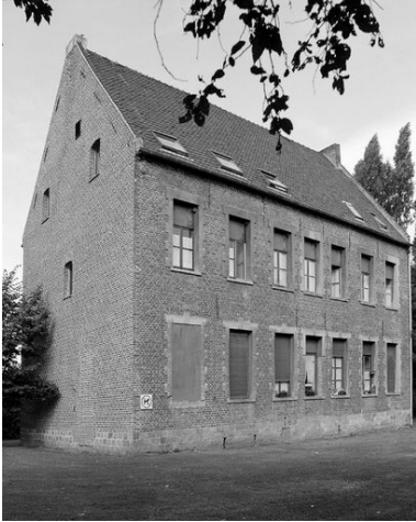
Vue générale de trois quarts de l'élévation postérieure. Phot. Philippe Dapvril IVR31_20045900462X
