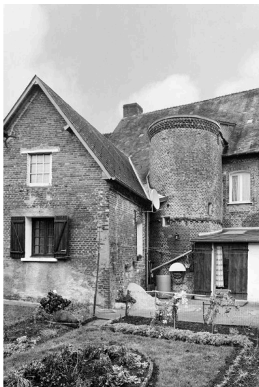
Détail de l'escalier hors-oeuvre de l'élévation postérieure sur le jardin. Phot. Pierre-Yves Brest IVR22_19990207314Z
