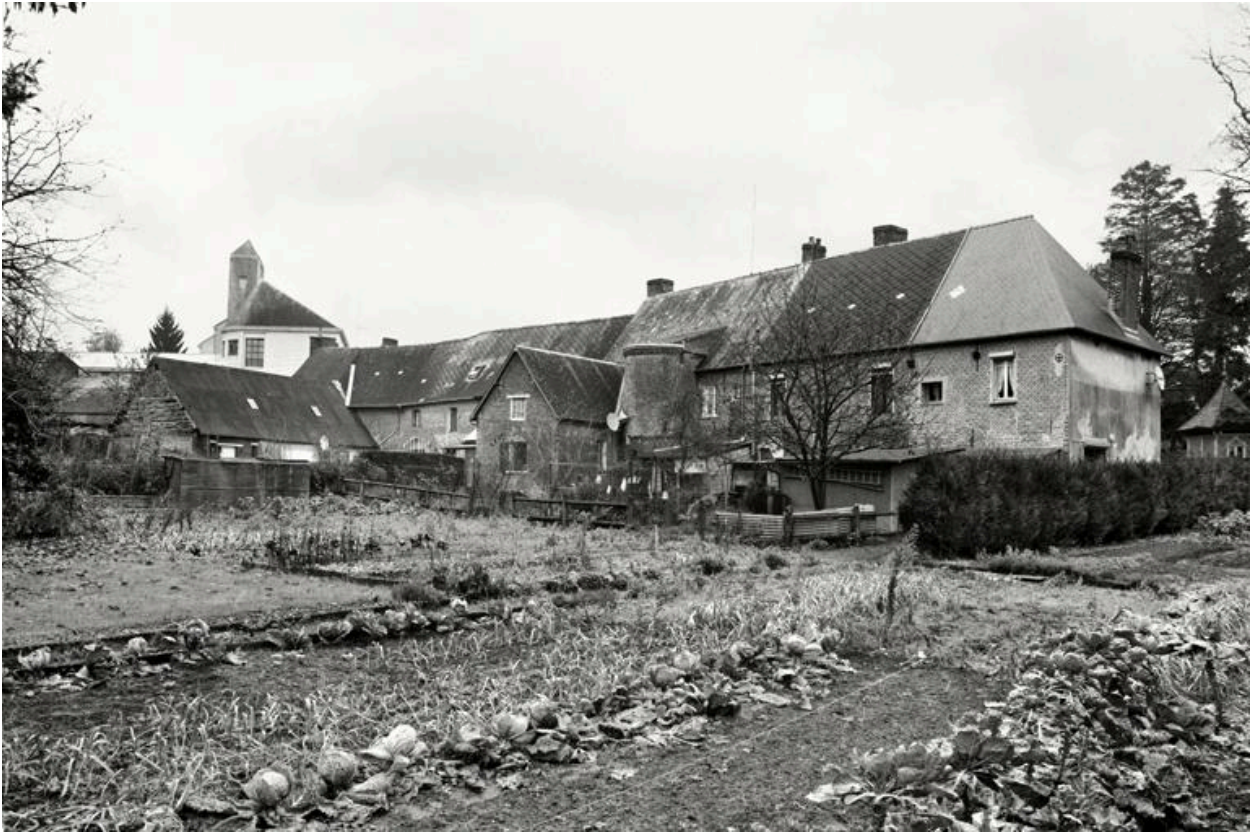
Vue de l'élévation postérieure sur le jardin.
