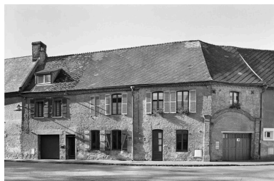
Vue de l'élévation sur la place, portant la date de 1750 et les initiales H. M. ou M. M. (?). Phot. Pierre-Yves Brest IVR22_19990207132Z
