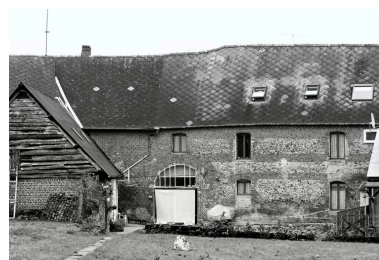
Vue de l'élévation postérieure sur la cour, construite en silex et brique. Phot. Pierre-Yves Brest IVR22_19990207318Z
