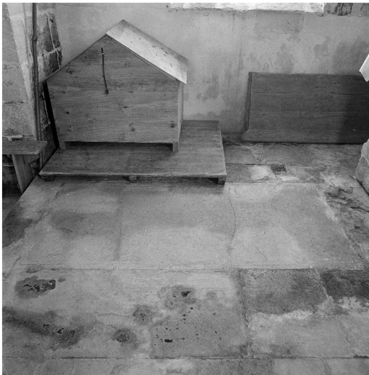
Vue générale de la dalle.
