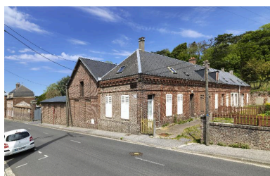
Vue générale. Phot. Thierry Lefébure IVR22_20158000348NUC2AQ
