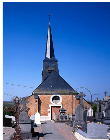
Vue de la façade occidentale. Phot. Franck Bürjes IVR22_19990201275VA
