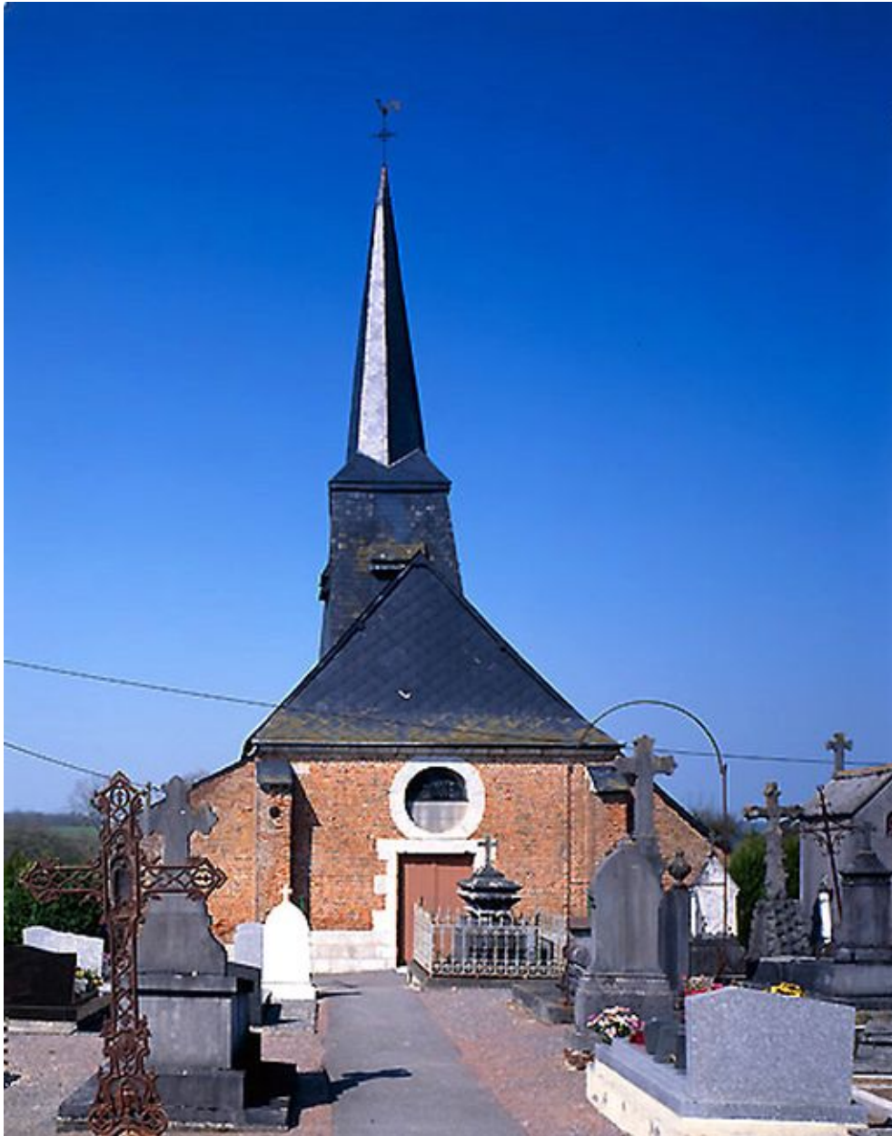
Vue de la façade occidentale.
