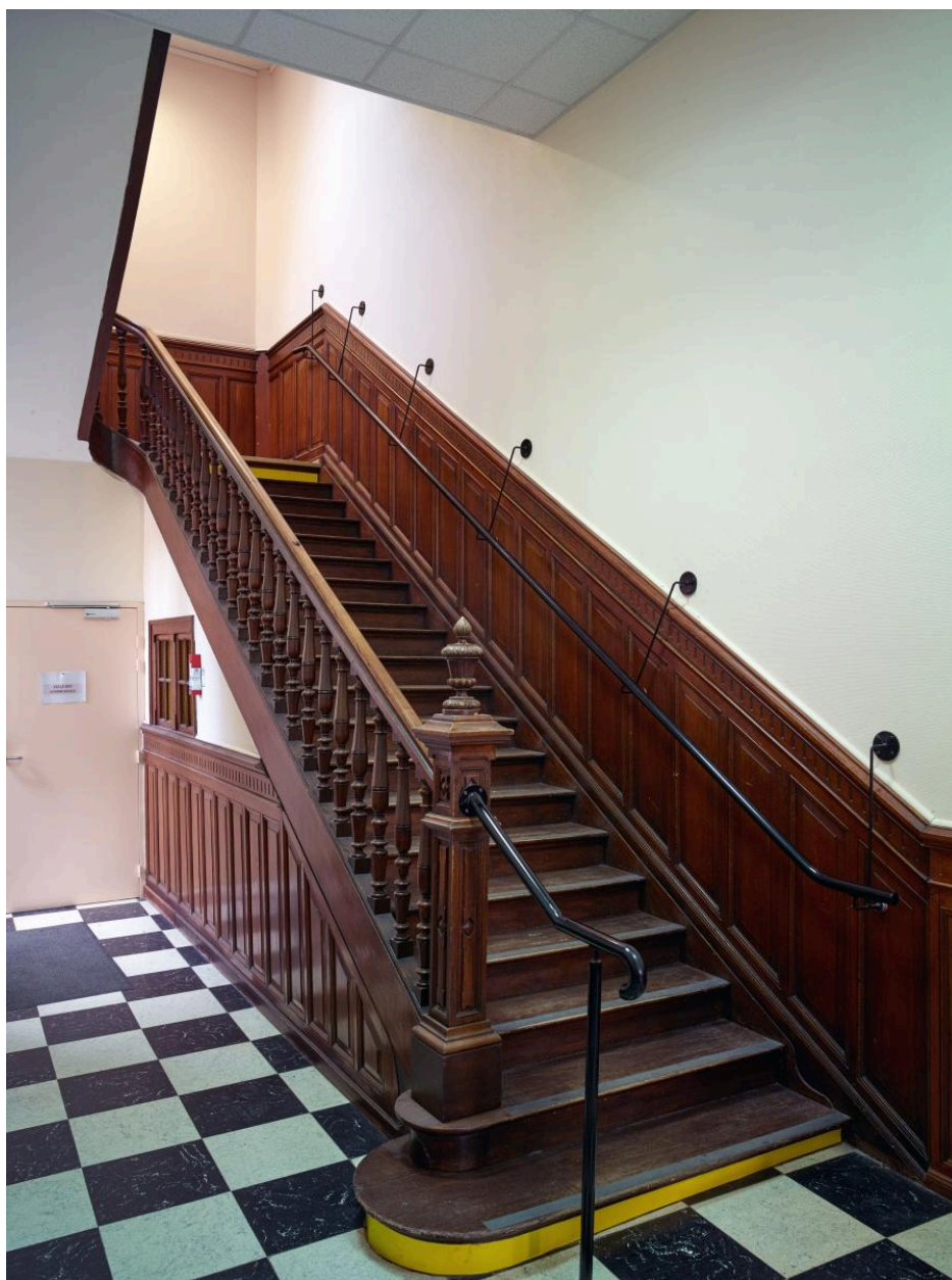
Escalier central tournant de l'aile de l'Horloge à volées droites et repos. Vue de la première volée.
