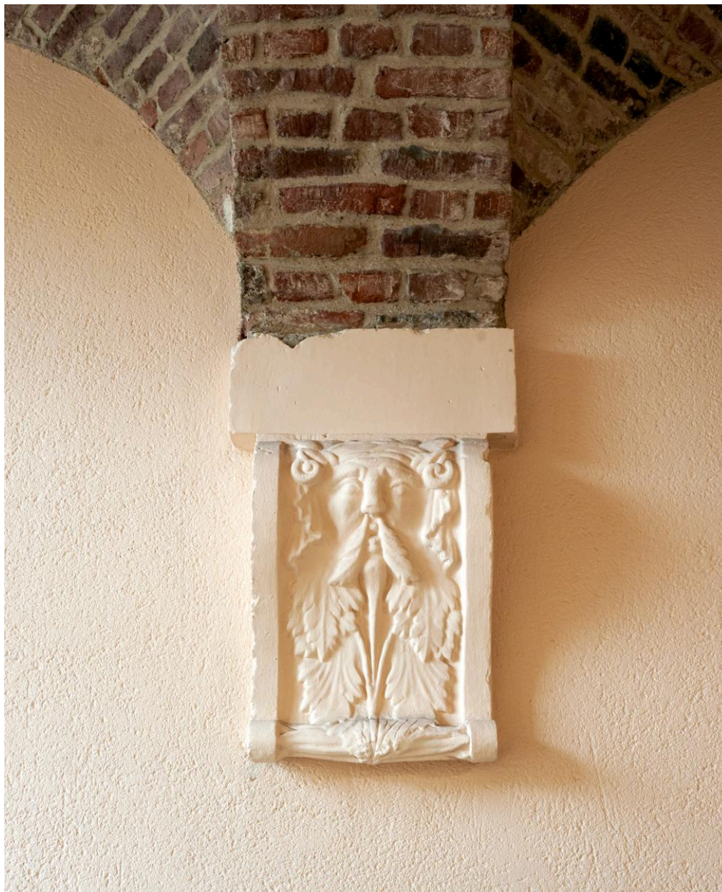
Détail d'une retombée de voûte du couloir longeant la bibliothèque et menant à l'ancien cloître (actuel CDI du lycée).
