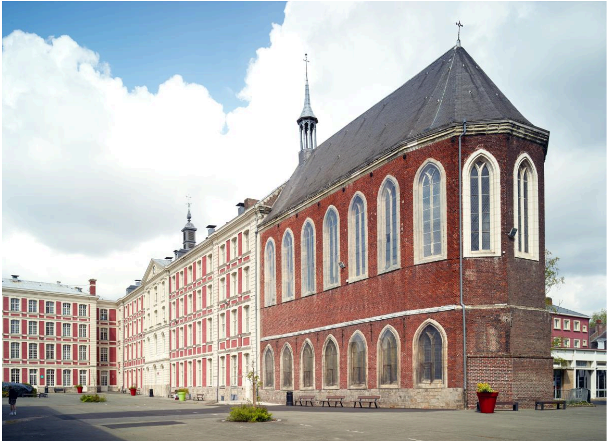
Vue de la chapelle, de l'aile de l'Horloge et de l'aile de la rue Saint-Albin depuis la cour des élèves.
