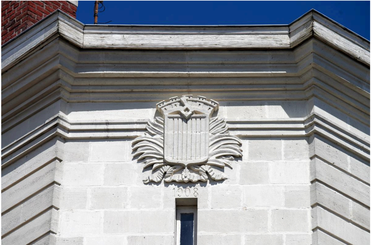
Écusson avec la date portée de 1908, situé sous la corniche à l'angle du bâtiment, au croisement des rues Saint-Albin et Saint-Benoît.
