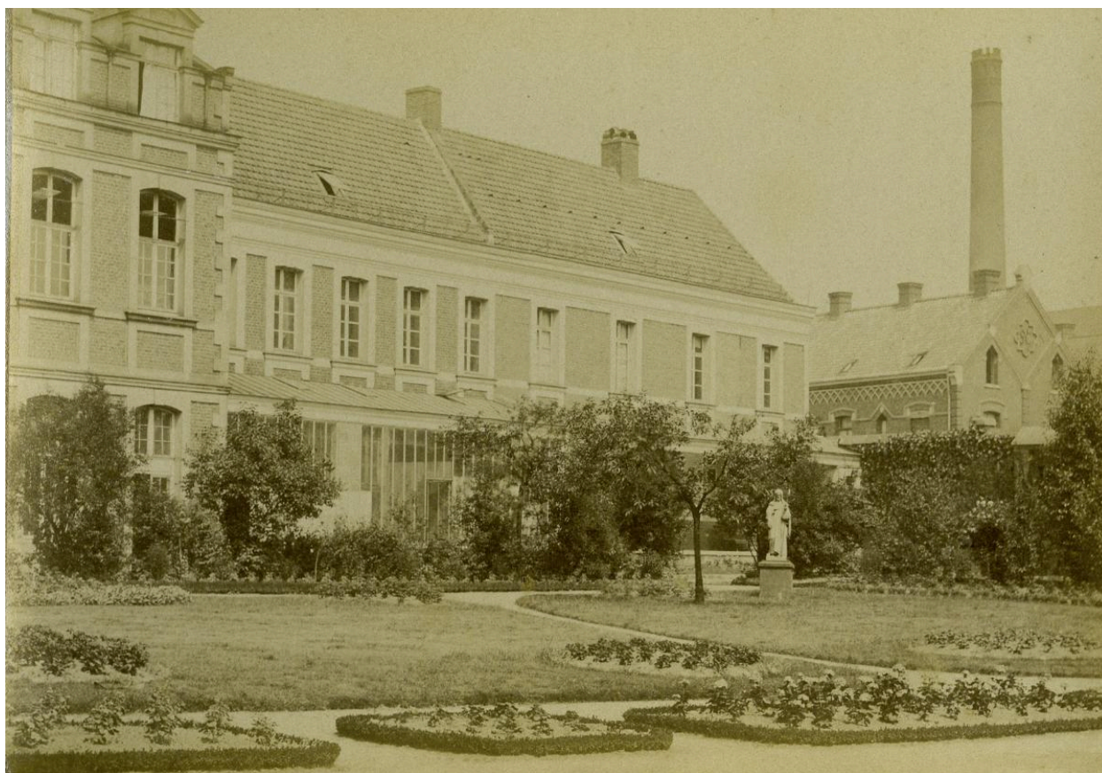
Extrémité nord de l'aile longeant la rue Saint-Albin depuis la cour d'honneur (actuel jardin). Photographie, avant 1903.
