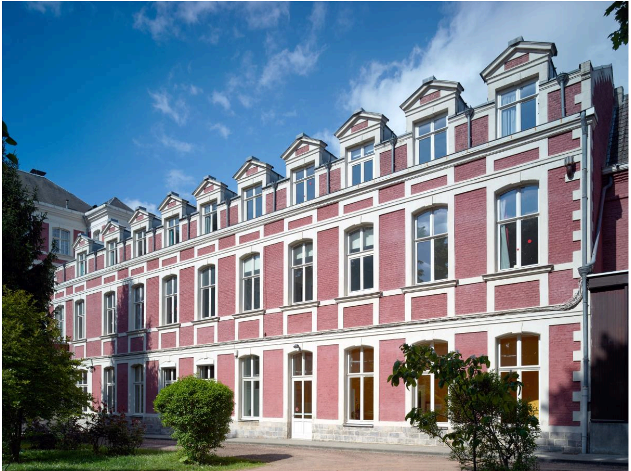
Vue de la partie de l'aile bordant la rue Saint-Albin depuis la cour d'honneur.
