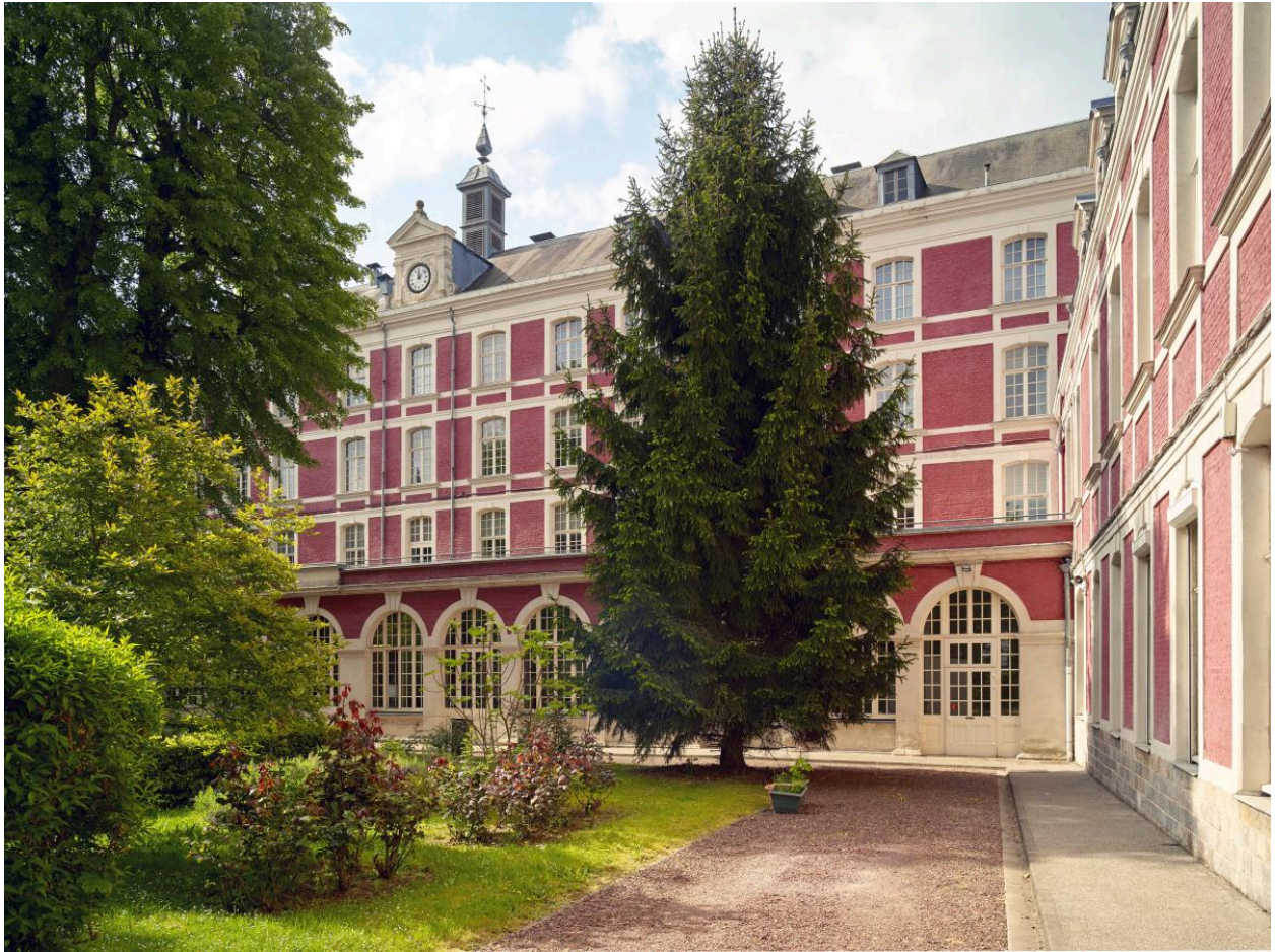
Vue de la partie ouest de l'aile de l'Horloge depuis la cour d'honneur, avec le retour de l'aile bordant la rue Saint-Albin.
