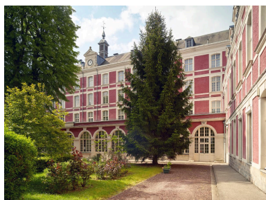
Vue de la partie ouest de l'aile de l'Horloge depuis la cour d'honneur, avec le retour de l'aile bordant la rue Saint-Albin. Phot. Pierre Thibaut IVR32_20225900242NUCA
