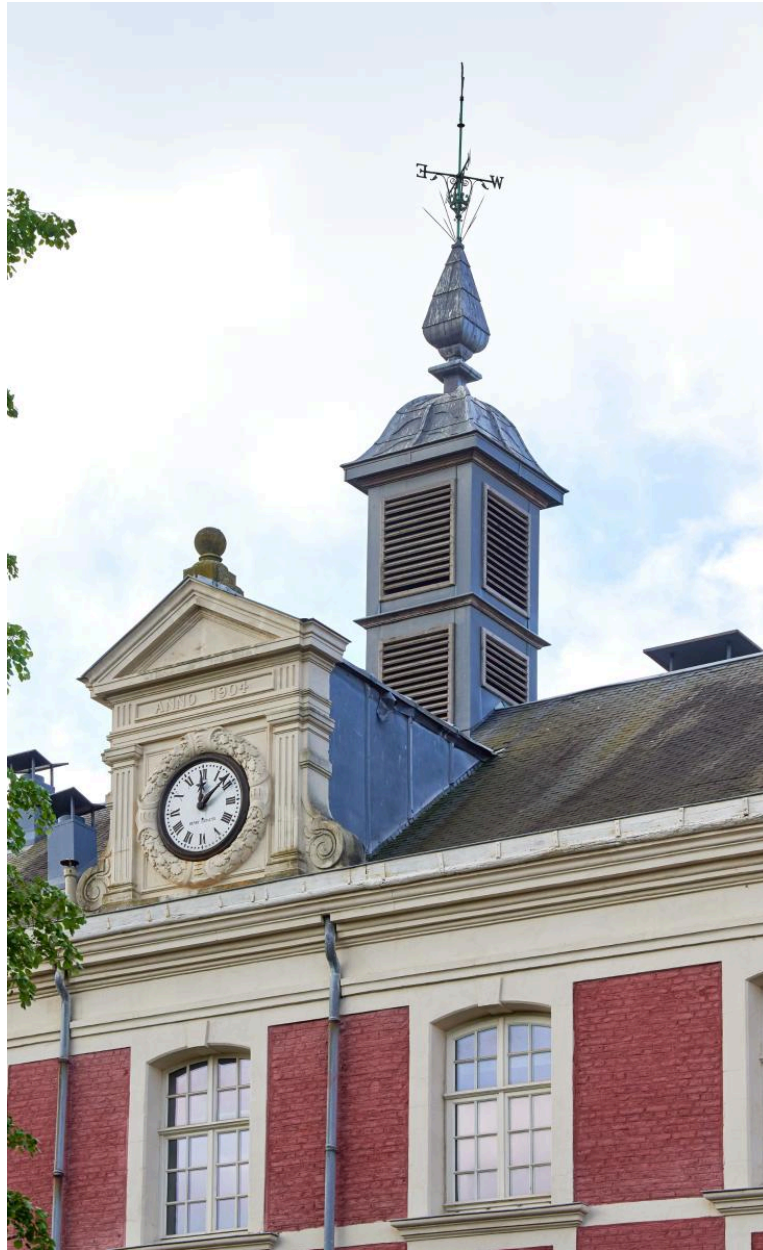
Détail de la lucarne à fronton triangulaire couonnant la travée centrale de l'aile de l'Horloge sur la cour d'honneur.
