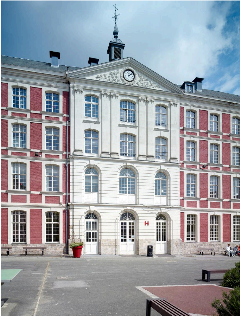
Détail de l'avant-corps central de l'aile de l'Horloge.
