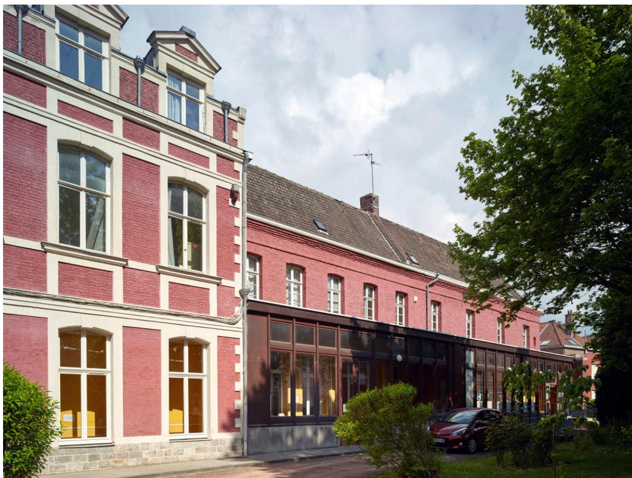
Extension de l'aile bordant la rue Saint-Albin depuis la cour d'honneur.
