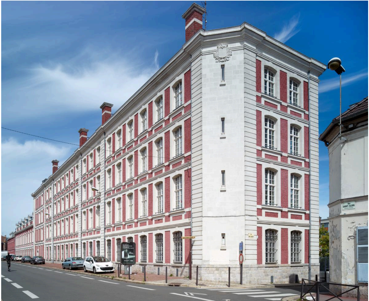
Vue générale de la façade sur la rue Saint-Albin, orientée ouest-nord. Au premier plan, le bâtiment de 1780, rehaussé en 1853 puis 1906.
