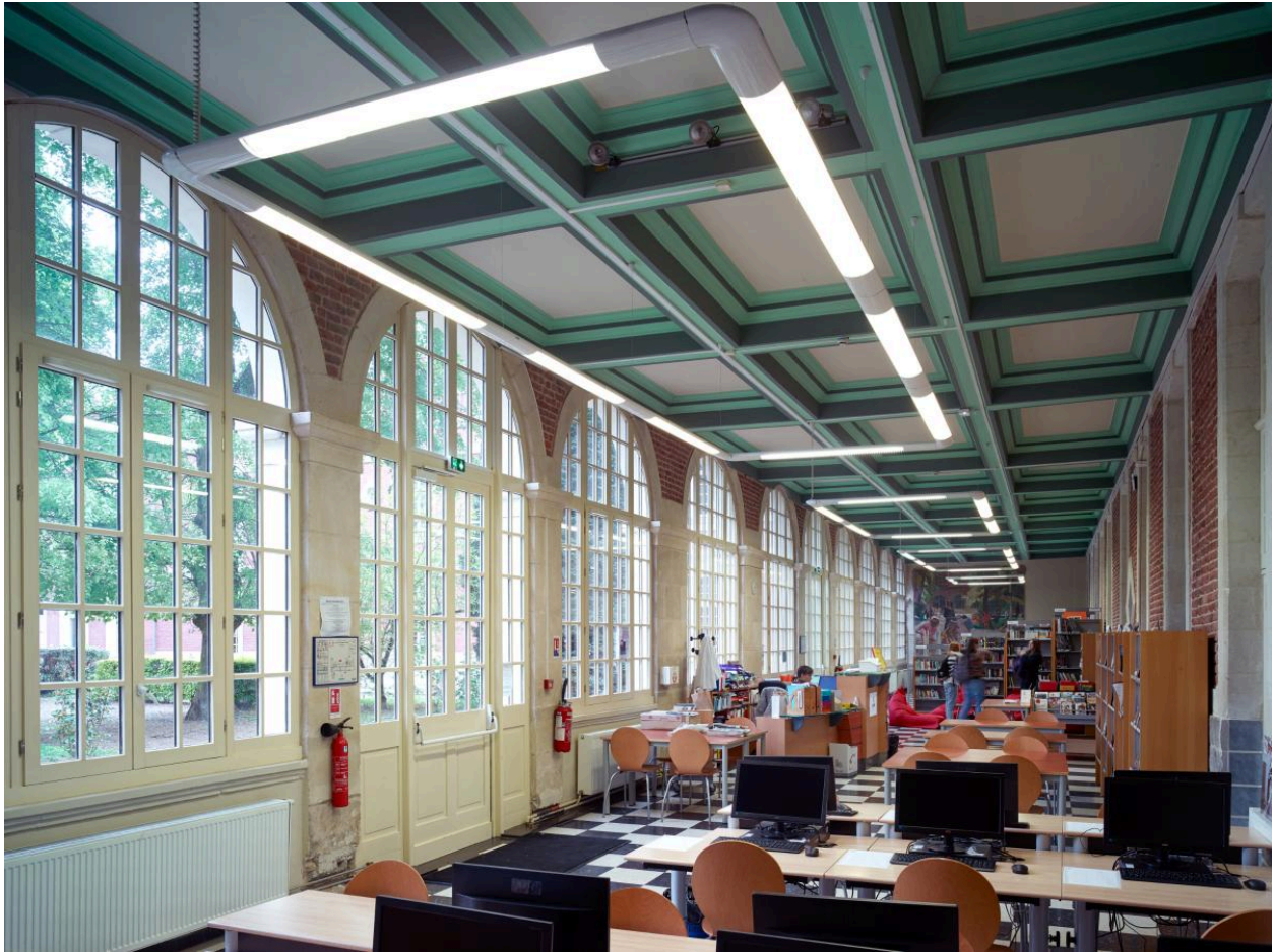
Vue orientée ouest-est de l'ancien cloître (actuel CDI du lycée) avec vue sur les baies construites en 1896 pour fermer le cloître.
