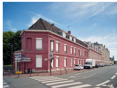
Vue de l'extrémité nord de la façade sur la rue Saint-Albin (bâtiment construit vers 1900). Phot. Pierre Thibaut IVR32_20225900441NUCA
