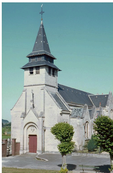
Elévation sud-ouest. Phot. Martine Plouvier IVR22_19836000310ZA
