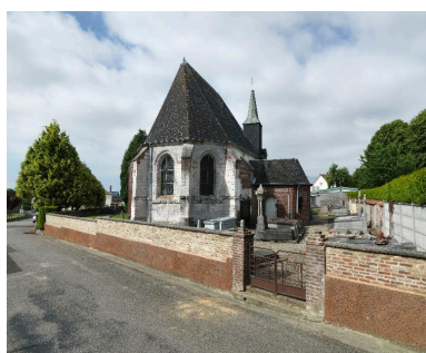
Vue du chevet et de la sacristie. Phot. Thierry Lefébure IVR22_20148000397NUC2A
