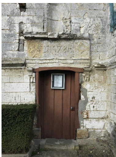
Détail du fronton de la porte d'entrée. Phot. Thierry Lefébure IVR22_20148000669NUC2A
