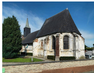
Vue de trois-quarts de l'église. Phot. Thierry Lefébure IVR22_20148000396NUC2A
