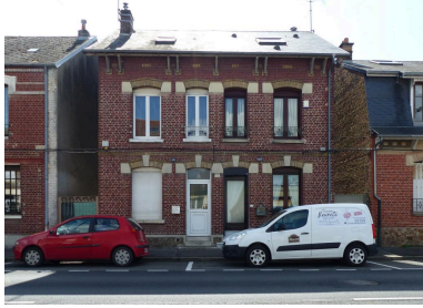
Vue de la façade sur rue. Phot. Isabelle Barbedor IVR32_20210205193NUCA
