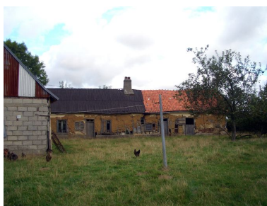
Vue de face du logis et des écuries. Phot. Inès Guérin IVR22_20068005736NUCA
