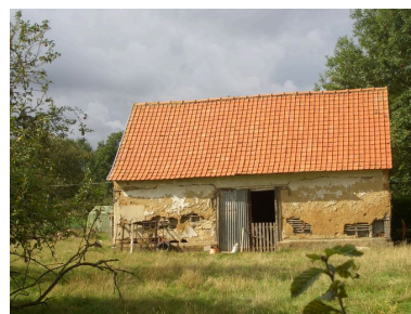
Vue de la grange. Phot. Inès Guérin IVR22_20068005743NUCA
