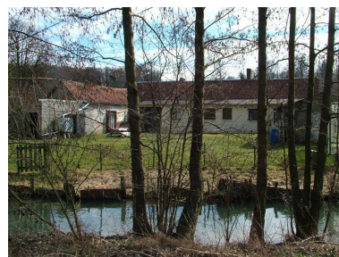
Vue générale depuis la rivière. Phot. Frédéric Fournis IVR22_20108001066NUCA
