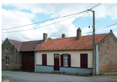
Vue générale de face. Phot. Frédéric Fournis IVR22_20098005288NUCA
