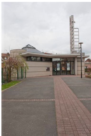
Elévation postérieure. Phot. Pierre Thibaut IVR31_20145903140NUCA
