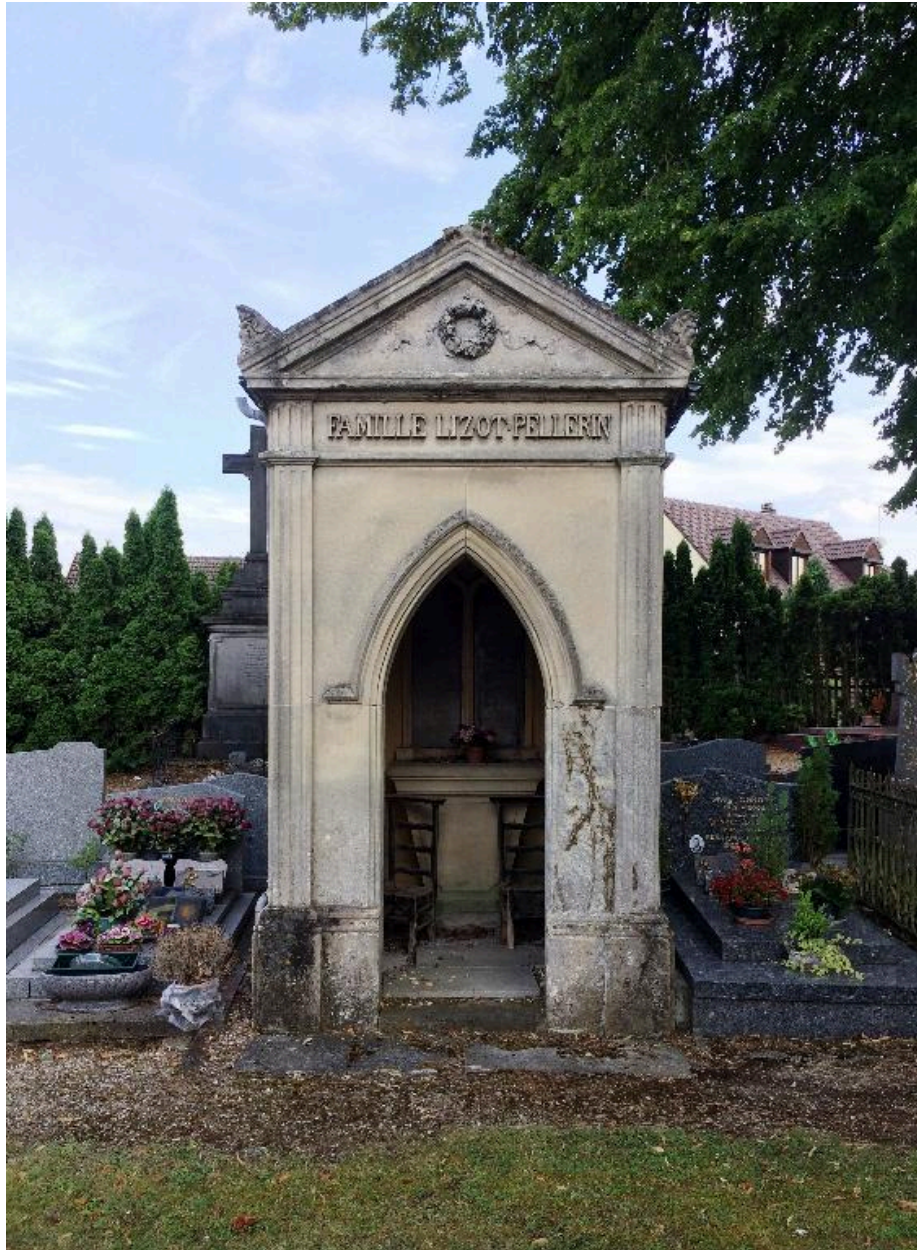
Vue de la façade antérieure.
