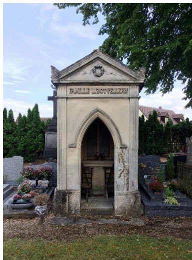
Vue de la façade antérieure. Phot. Isabelle Barbedor IVR32_20178005176NUCA
