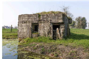
Vue de trois-quarts vers le nord-ouest Phot. Jean-Marc Ramette IVR31_20145905526NUCA
