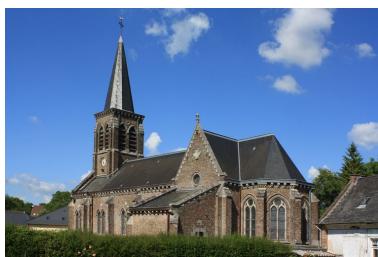
Vue d'ensemble sud-est de l'église.
