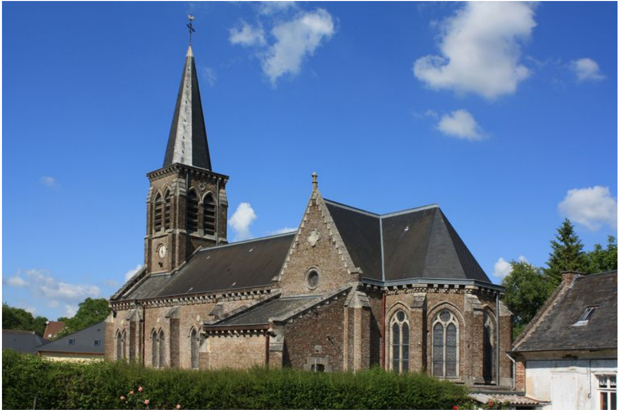
Vue d'ensemble sud-est de l'église.
