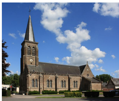
Vue d'ensemble, depuis la place aménagée au nord-ouest de l'église.
