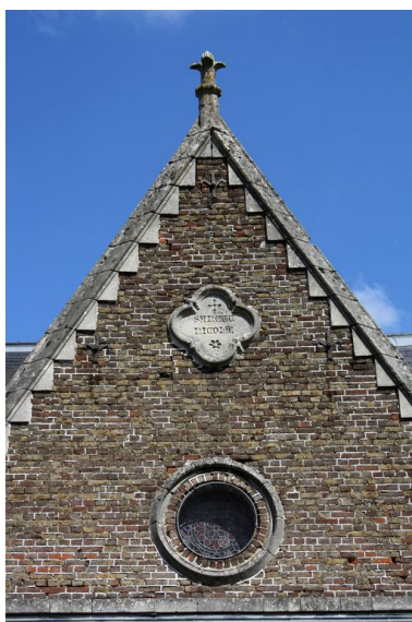
Pignon du transept nord-ouest.
