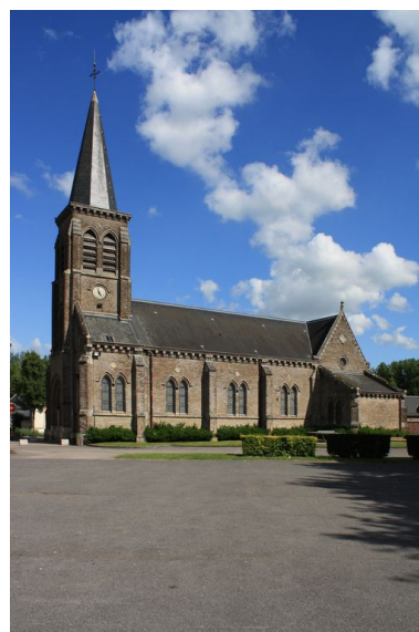
Vue générale. Phot. Bertrand Fournier IVR22_20088015422NUCA
