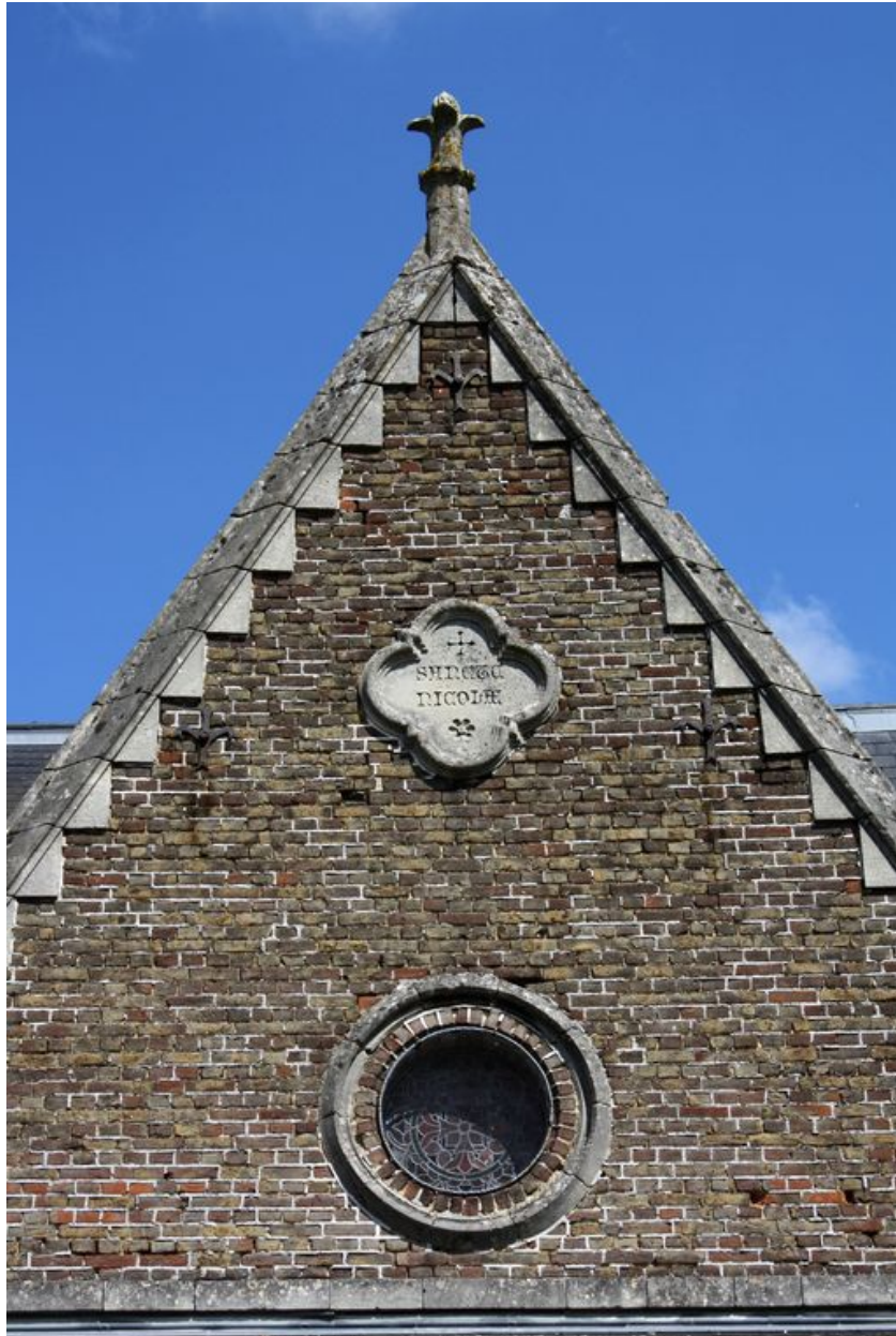
Pignon du transept nord-ouest.
