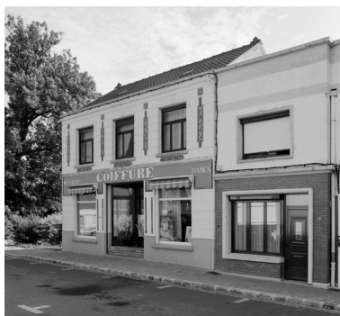
Vue générale. Phot. Philippe Dapvril IVR31_20045900458X
