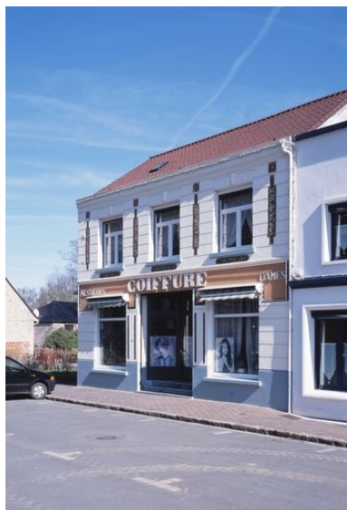
Vue générale. Phot. Pierre Thibaut IVR31_20095902008XA
