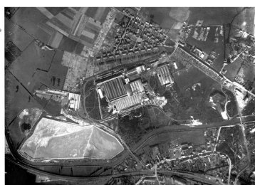
La glacierie de Bousois au centre de cette photographie aérienne de 1929. Au nord, la Cité du
