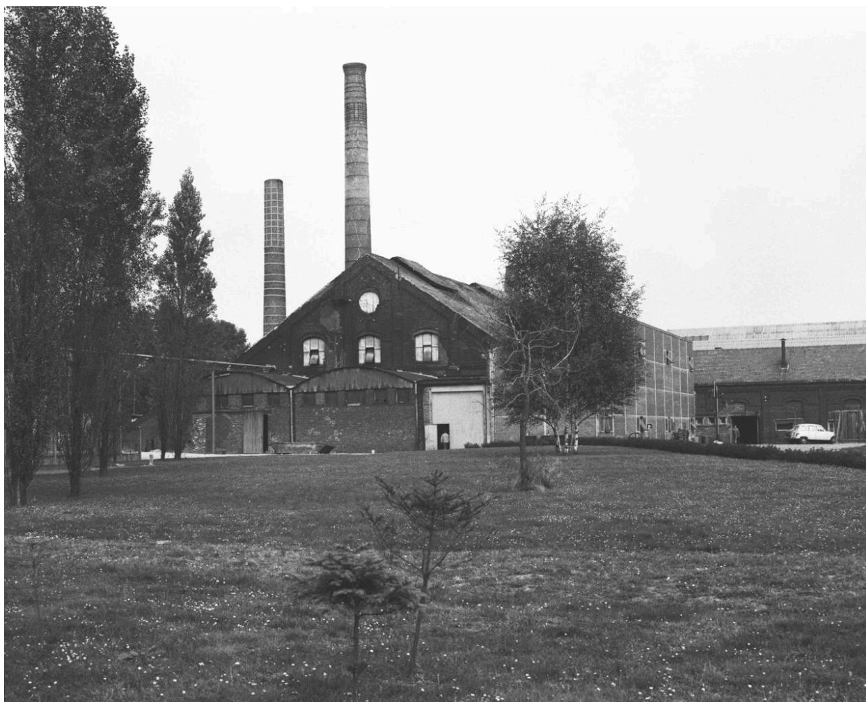
Vue générale de la halle à pots et la poterie du bas.
