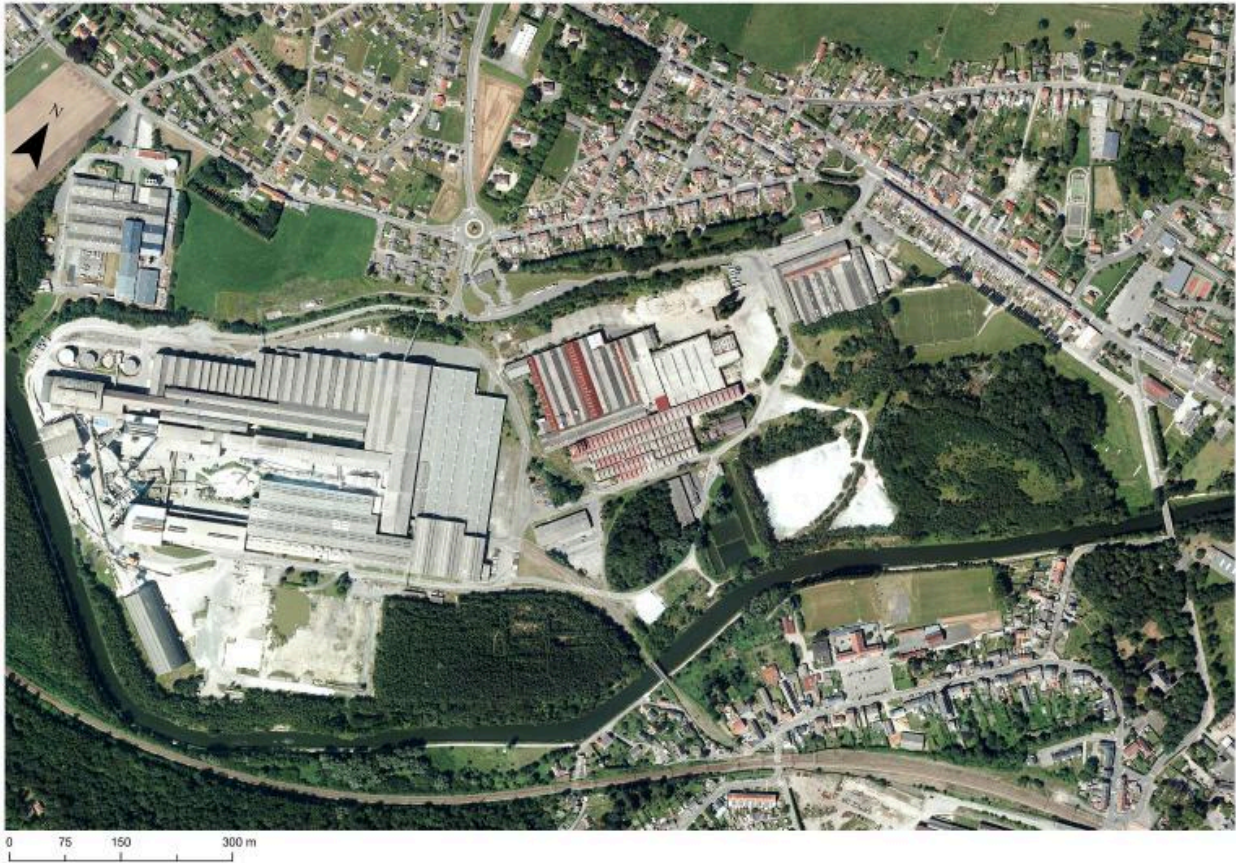
La glacerie de Boussois. Photographie aérienne, 2015. L'usine s'est développée sur l'ancien crassier (commune d'Assevent). La partie historique, encore visible à l'est, a depuis en grande partie disparu (Source IGN. Photothèque nationale. 2015).
