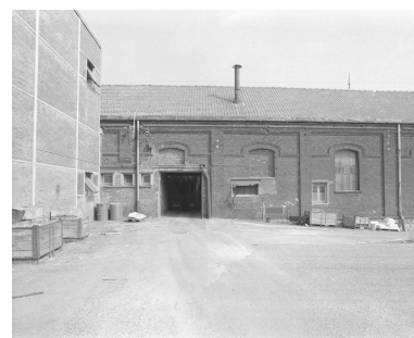
Sortie de la halle à pots. Phot. Philippe Caudroit IVR31_19795900019X
