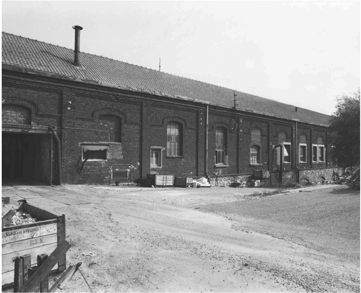
Vue générale de la halle à coulée.
