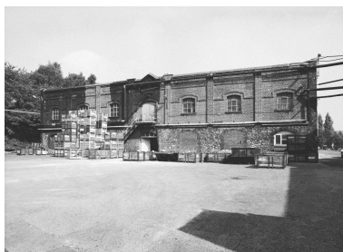
Élévation latérale de la poterie du haut, vue depuis la halle à pots (détruite vers 1980). Phot. Philippe Caudroit IVR31_19795900003X
