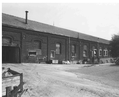
Vue générale de la halle à coulée. Phot. Philippe Caudroit IVR31_19795901914X
