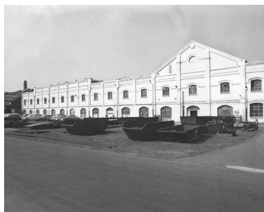
Élévation antérieure de la poterie du haut (détruite vers 1980). Phot. Philippe Caudroit IVR31_19795900005X
