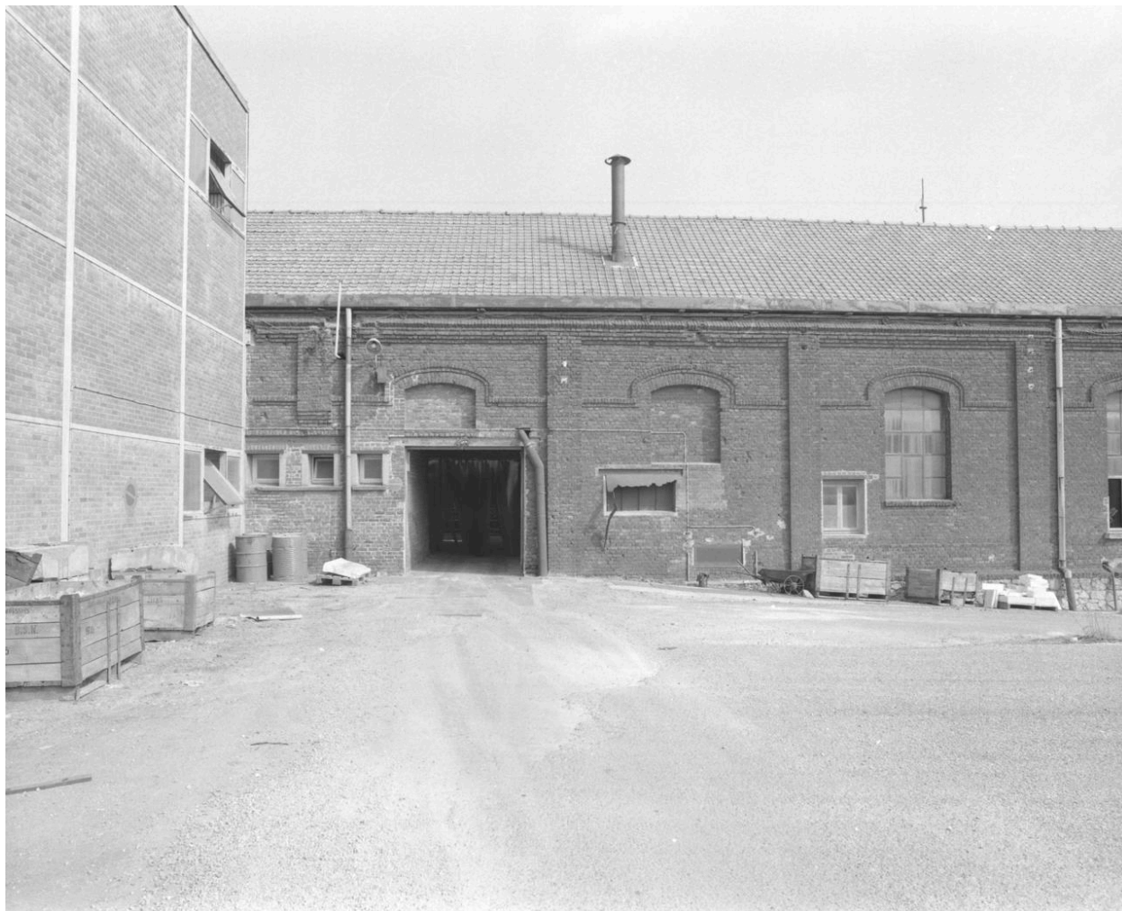
Sortie de la halle à pots.
