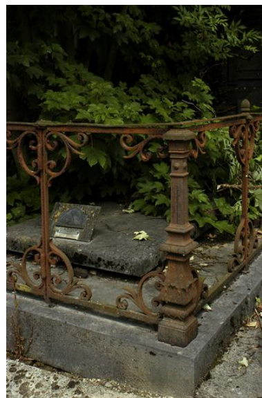
Détail de la grille. Phot. Thierry Lefébure IVR22_20058001347NUCA
