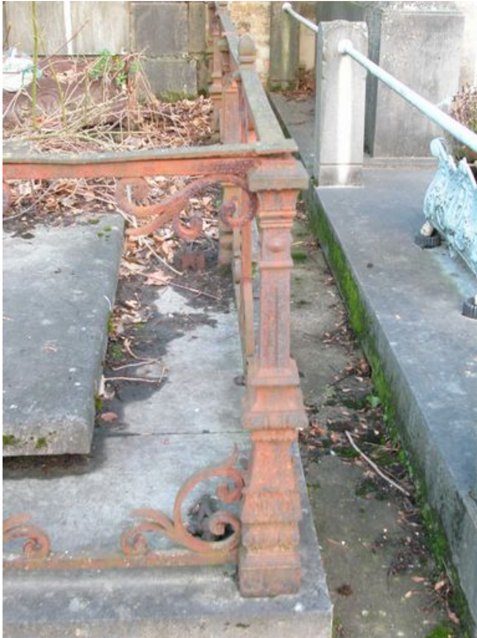
Détail d'un pilier de la grille.
