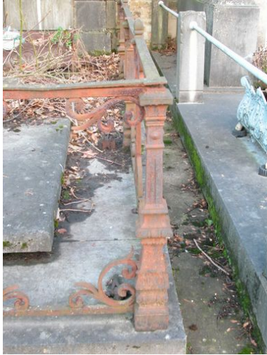
Détail d'un pilier de la grille. Phot. Laurent Nicolas IVR22_20058002198NUCA
