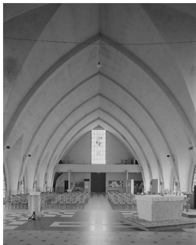
Vue intérieure vers l'ouest. Phot. Thierry Lefébure IVR22_19968000252V
