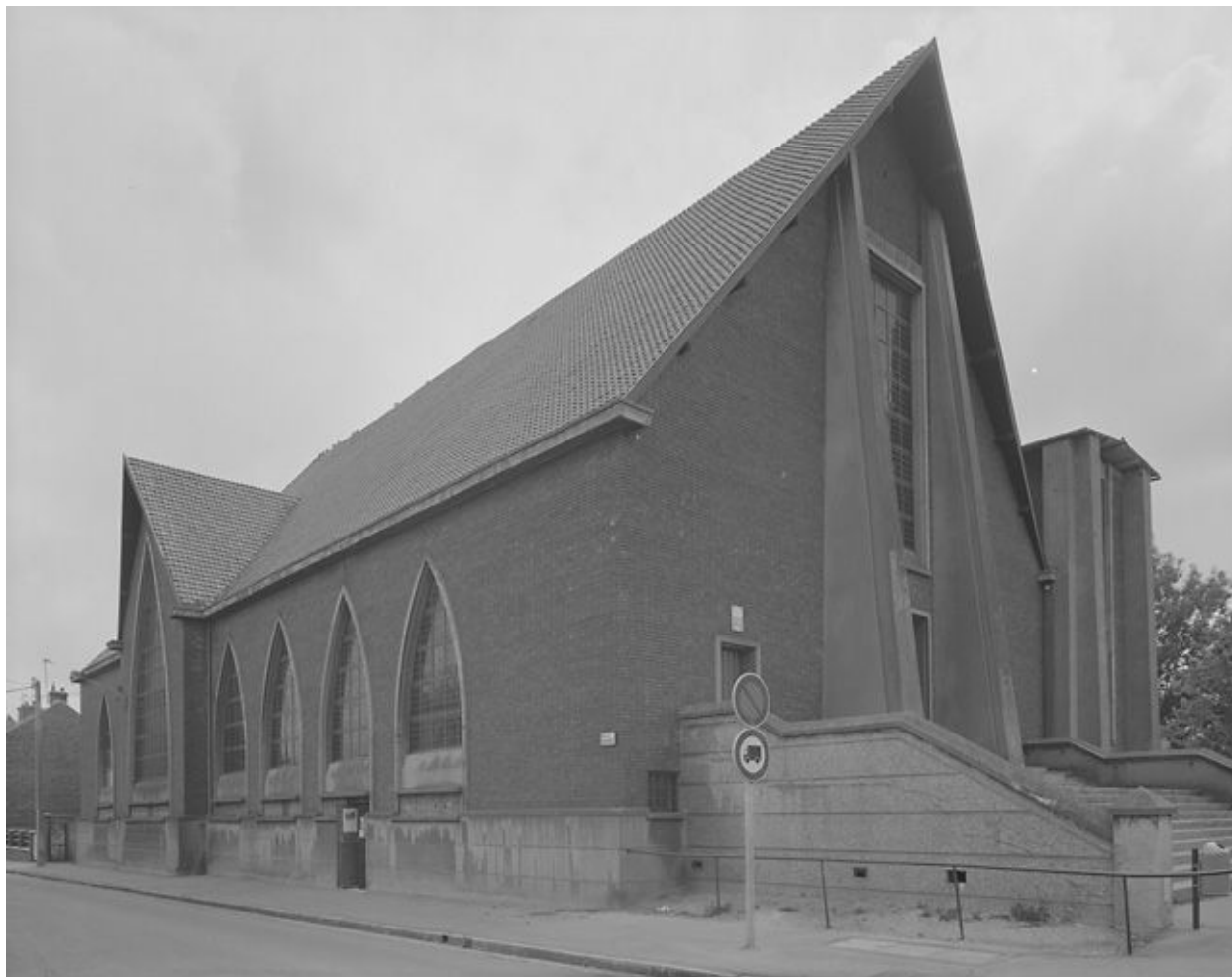
Vue générale sur la façade nord.
