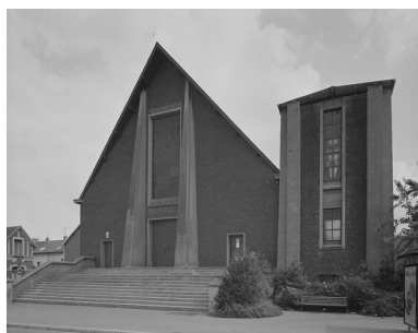
Vue générale depuis l'ouest. Phot. Thierry Lefébure IVR22_19968000249V
