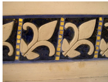
L'autel du bas-côté ouest : détail sur le décor de faïence. Phot. Isabelle Barbedor IVR22_20038010357NUCA
