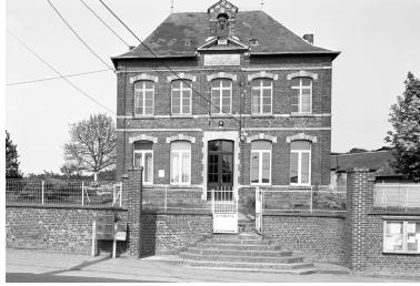
Façade principale. Phot. Thierry Lefébure IVR22_19930200473X
