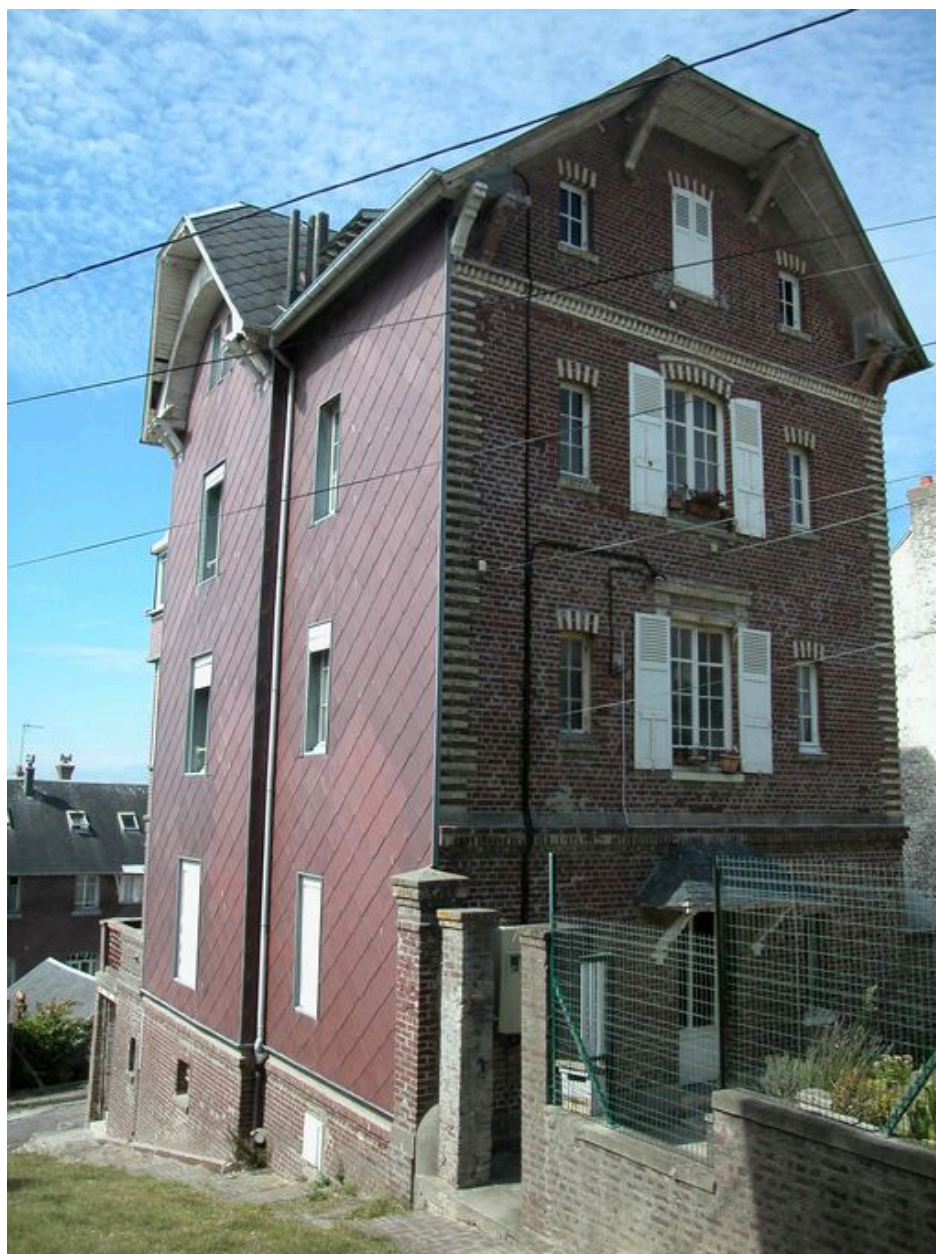
Vue de trois-quarts depuis le sud, façade postérieure et façade latérale essentée en ardoises.
