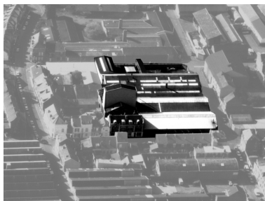
Vue aérienne du site en 1989. Phot. Pillet Frédéric, Autr. Phot'R IVR22_20050206264NUCA
