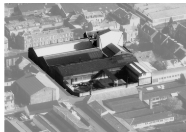
Vue aérienne du site en 1989. Phot. Pillet Frédéric, Autr. Phot'R IVR22_20050206265NUCA
