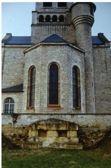
Vue générale. Phot. Thierry Hardier IVR22_20050200507NUCA
