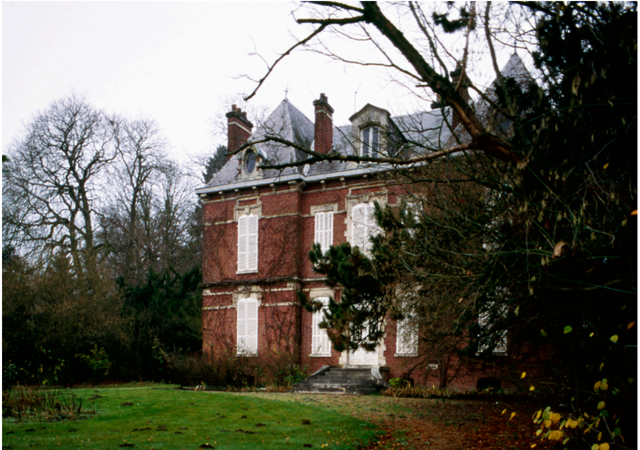
Vue de la façade.
