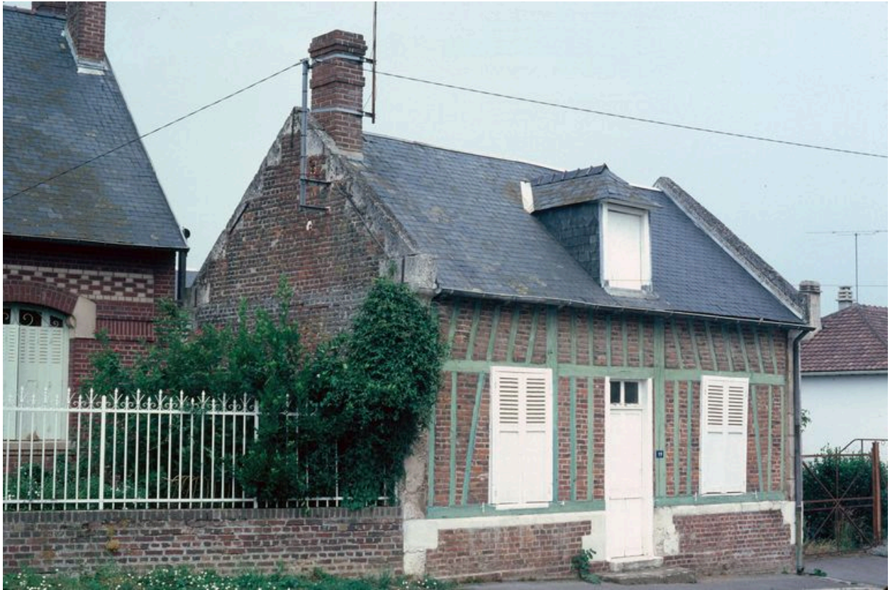
Maison en pan de bois hourdé en briques.
