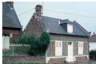
Maison en pan de bois hourdé en briques. Phot. Martine Plouvier IVR22_19836000294ZA
