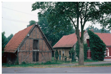
Maison et grange en pan de bois hourdé en briques, rue de la Place. Phot. Martine Plouvier IVR22_19836000289ZA
