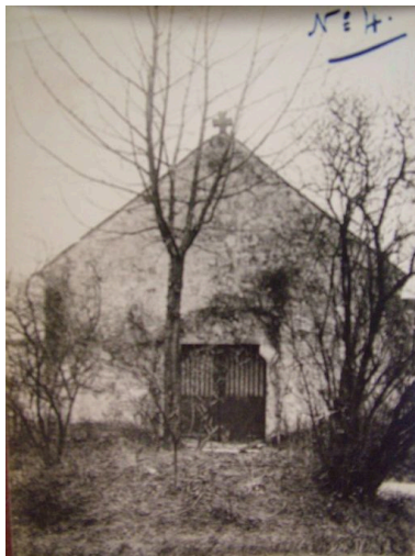
Vue ancienne de l'extérieur de la chapelle (AD Aisne : 15 R 1336). Phot. Inès Guérin IVR22_20030202885NUCAB
