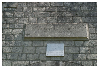
Vue d'une plaque fixée au mur latéral gauche. Phot. Inès Guérin IVR22_20030202675NUCA
