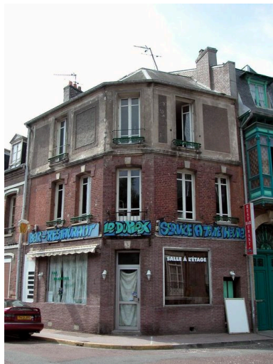
Vue d'ensemble. Phot. Elisabeth Justome IVR22_20038005390NUCA
