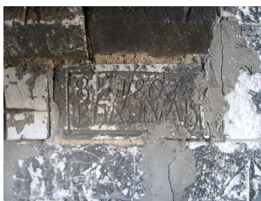
Mur nord du bas-côté nord : Graffiti. Phot. Isabelle Barbedor IVR22_20078012854NUCA
