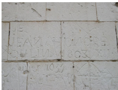
Mur nord du bas-côté nord : Graffiti. Phot. Isabelle Barbedor IVR22_20078012859NUCA
