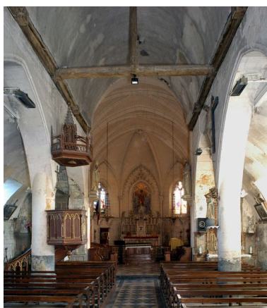
Vue intérieure vers le chœur. Phot. Thierry Lefébure IVR22_20078000254NUCA
