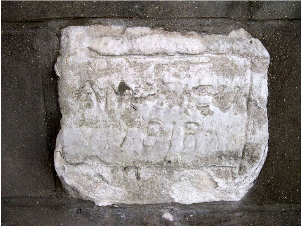
Mur nord du bas-côté nord : Graffiti.
