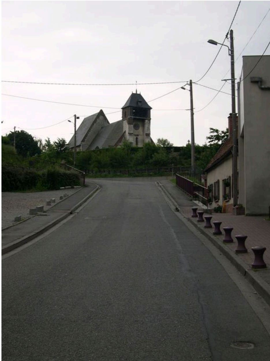
Vue de situation, depuis la rue Dufour.
