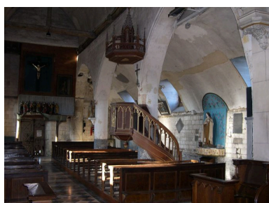
Vue intérieure de la nef et du bas-côté nord. Phot. Isabelle Barbedor IVR22_20078012735NUCA
