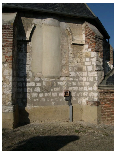
Mur est du choeur. Phot. Isabelle Barbedor IVR22_20078012849NUCA
