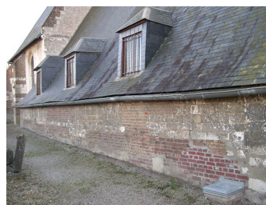
Vue du bas-côté nord. Phot. Isabelle Barbedor IVR22_20078012507NUCA
