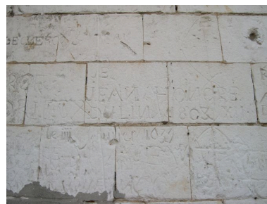
Mur nord du bas-côté nord : Graffiti. Phot. Isabelle Barbedor IVR22_20078012856NUCA
