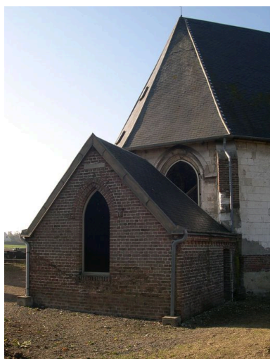
Vue de la sacristie. Phot. Isabelle Barbedor IVR22_20078012501NUCA
