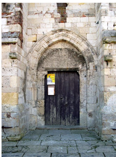
Vue du portail. Phot. Isabelle Barbedor IVR22_20078012503NUCA
