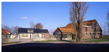
Vue générale. Phot. Irwin Leullier IVR22_20078000092NUC1A
