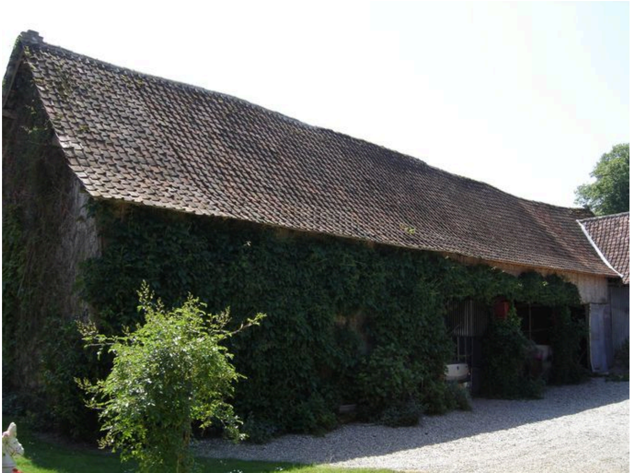
Vue de la grange depuis la cour.
