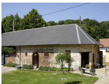
Vue des bâtiments situés au nord de la propriété depuis la cour. Phot. Inès Guérin IVR22_20058005912NUCA
