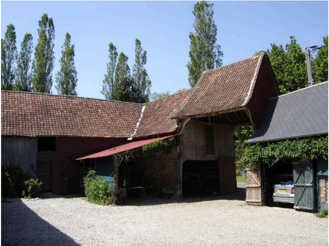
Vue du passage couvert et de la partie située à l'ouest de la cour.
