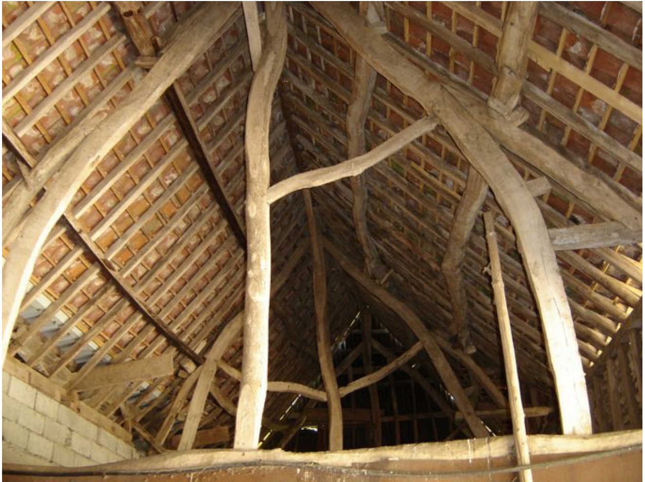
Vue de la charpente de la grange.
