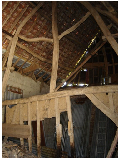
Vue intérieure des cloisons de la grange. Phot. Inès Guérin IVR22_20058005916NUCA
