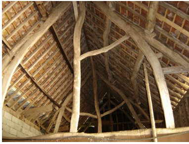
Vue de la charpente de la grange. Phot. Inès Guérin IVR22_20058005914NUCA
