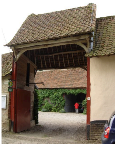
Vue du passage couvert depuis la rue. Phot. Inès Guérin IVR22_20058005908NUCA
