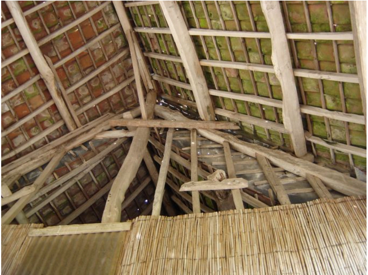
Vue de la charpente du passage couvert.
