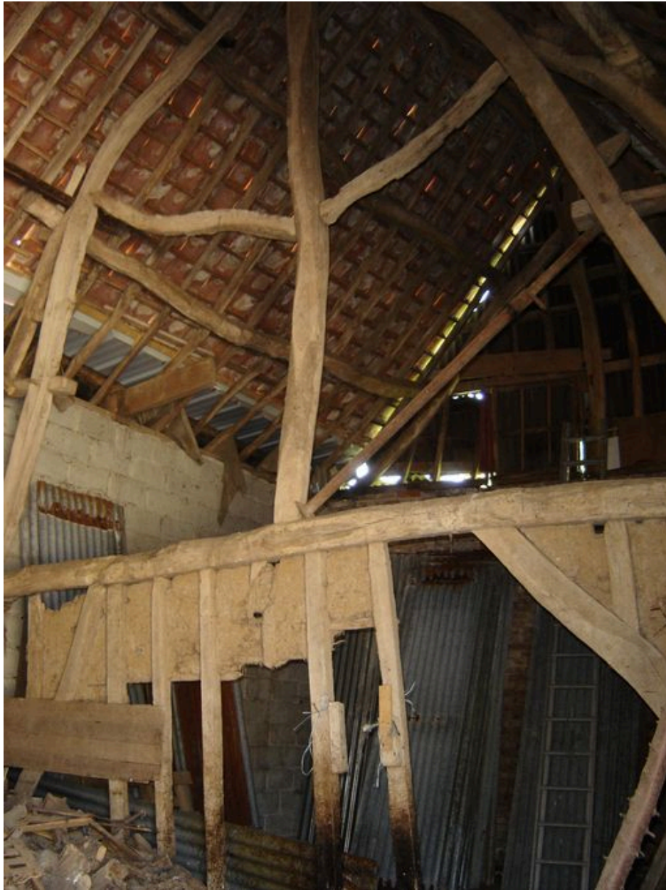
Vue intérieure des cloisons de la grange.
