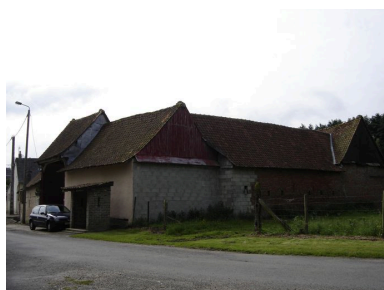
Vue générale depuis la rue. Phot. Inès Guérin IVR22_20058005907NUCA
