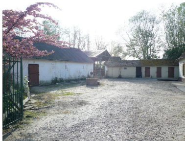
Vue de la cour et des dépendances. Phot. Inès Guérin IVR22_20078005922NUCA
