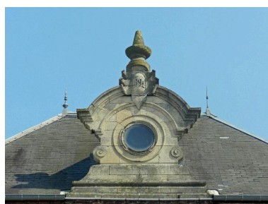
Détail du fronton portant la date 1892. Phot. Romain Grimaud IVR22_20138015969NUC1A
