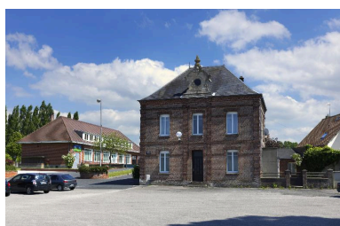
Vue générale. Phot. Thierry Lefébure IVR22_20158000582NUC2A
