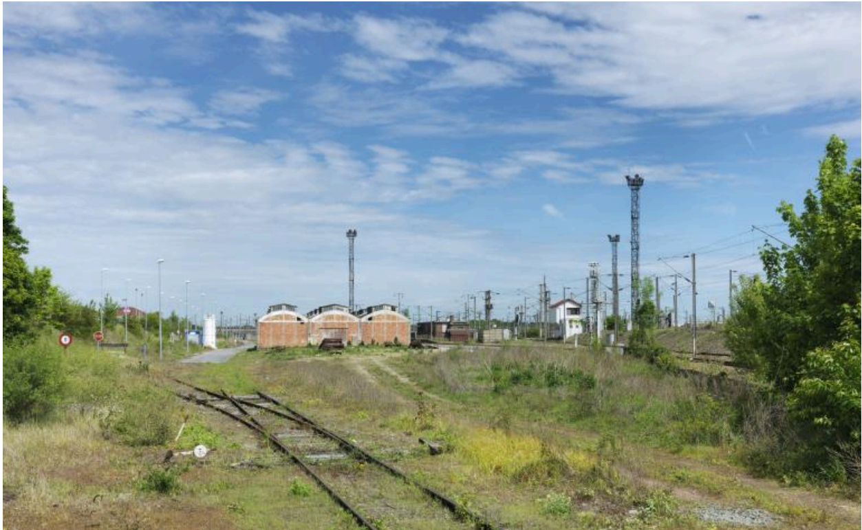
Vue des voies et des vestiges des anciennes halles de transbordement, au sud des ateliers.
