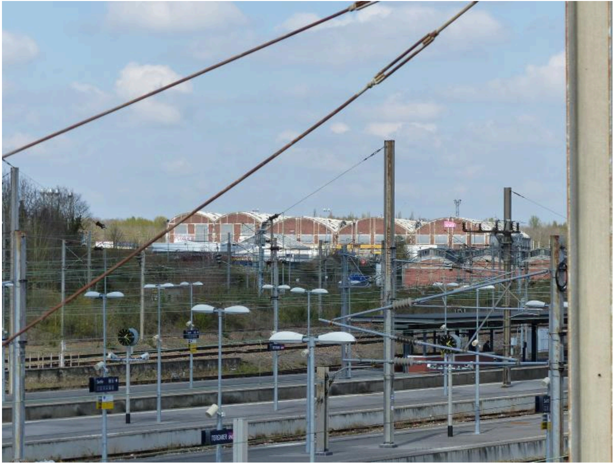
Vue de situation des ateliers du matériel roulant, depuis la passerelle de la gare.
