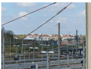
Vue de situation des ateliers du matériel roulant, depuis la passerelle de la gare.
