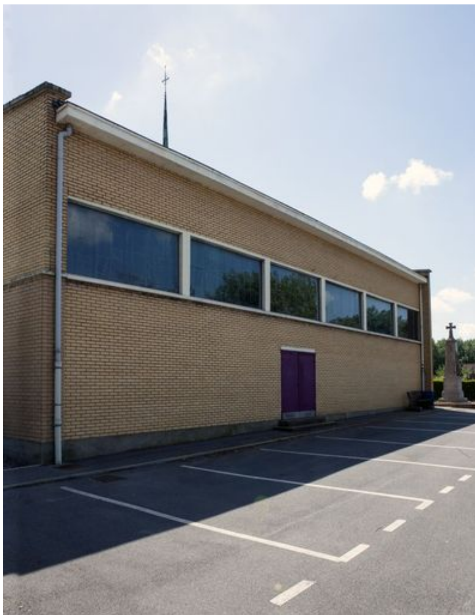
Vue latérale gauche depuis l'arrière de l'église.
