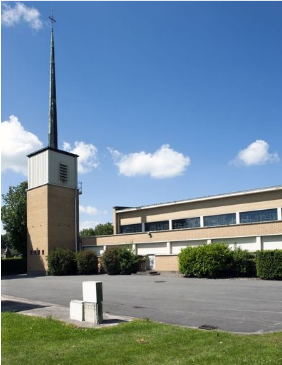
Vue latérale droite depuis l'arrière de l'église.
