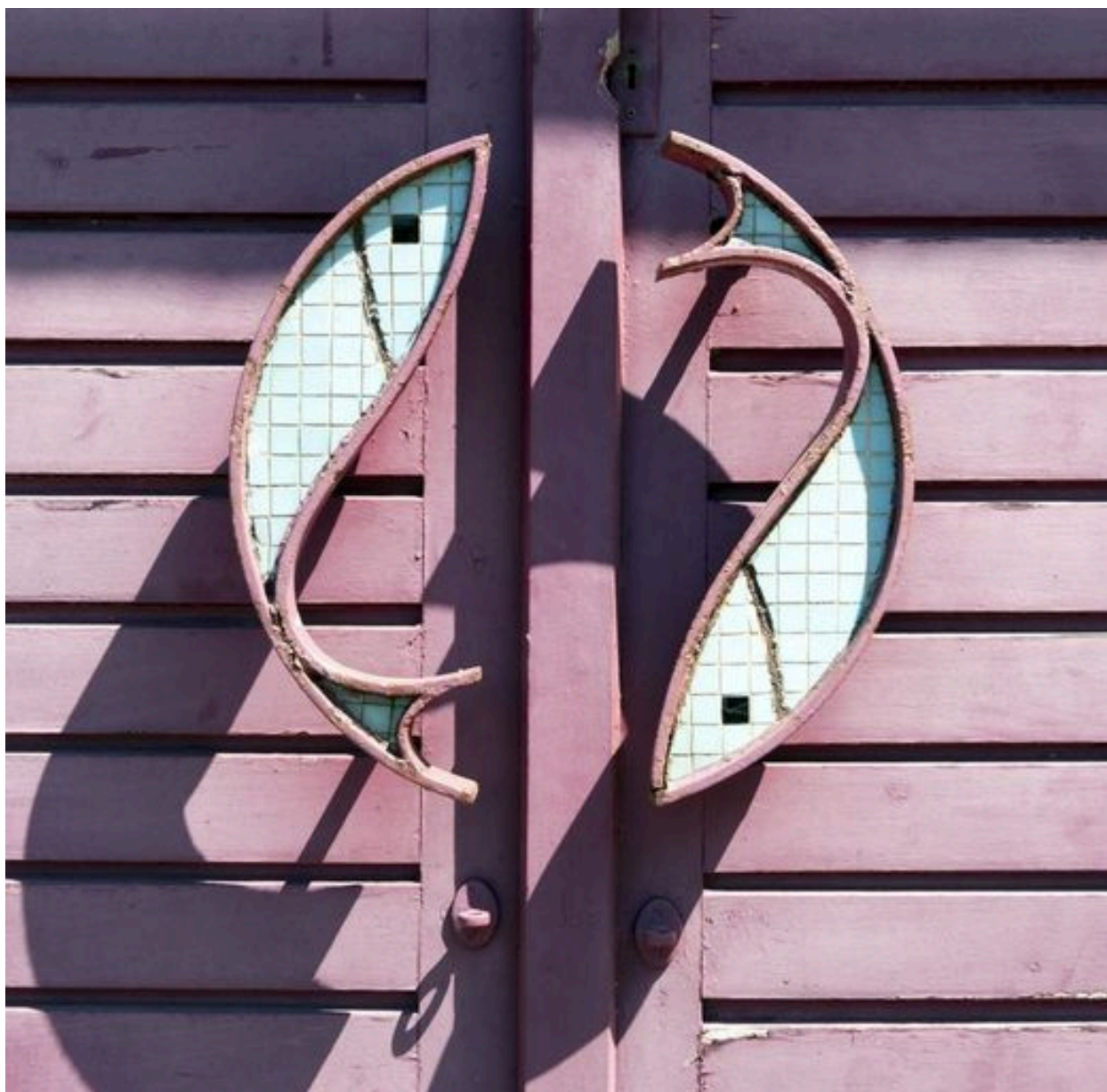
Détail de la porte d'entrée.
