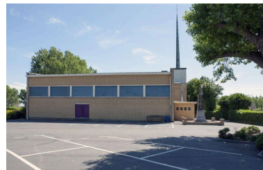
Flanc gauche. Phot. Pierre Thibaut IVR31_20155900714NUCA
