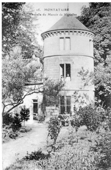
La tour du manoir de Vignolle détruite pour le projet d'extension de la cité non réalisé (AC Montataire).
