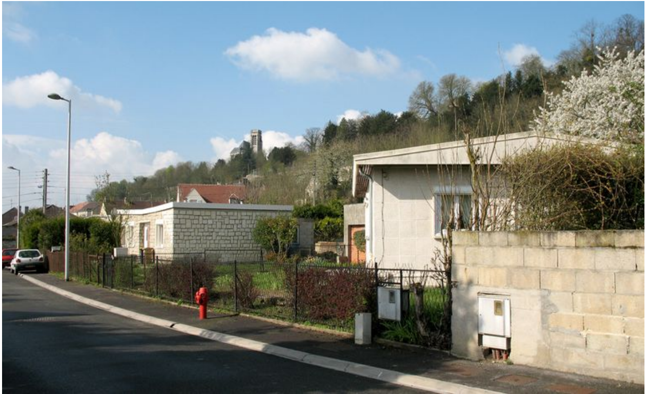
Deux types de maisons en rez-de-chaussée.
