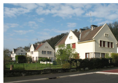
Trois maisons de type A de la cité Bessemer construites au début des années 1950.
