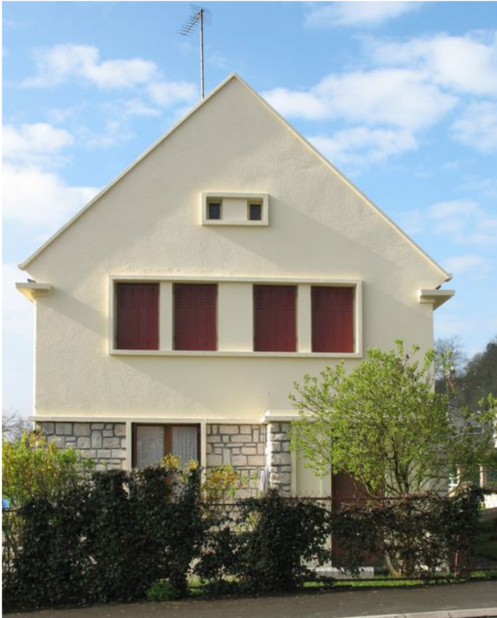
Pignon d'une maisonde type A de la cité Bessemer.
