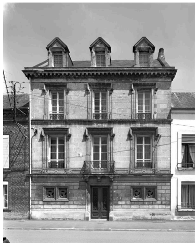
Vue de la façade sur rue. Phot. Franck Bürjes IVR22_19990203194V
