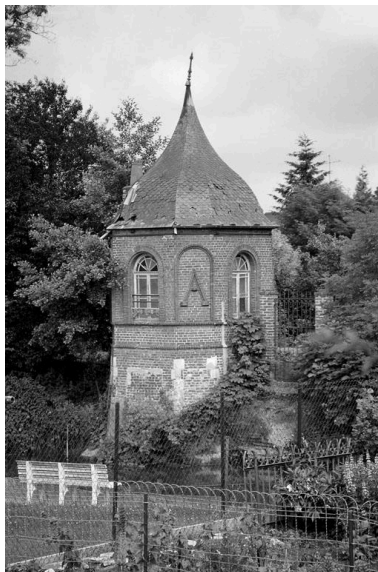
Vue du pavillon, construit au fond du jardin, au bord de l'Oise. Phot. Thierry Lefébure IVR22_19990206556Z
