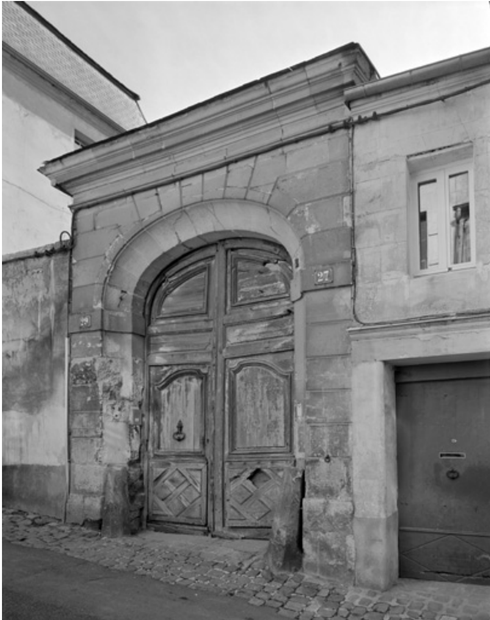
Le portail sur la rue du château.
