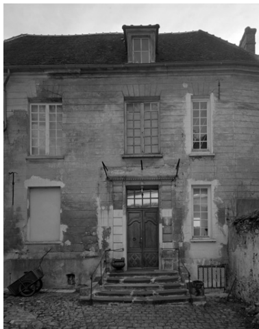
Elévation de la façade sur la cour. Phot. Thierry Lefébure IVR22_19940201132V
