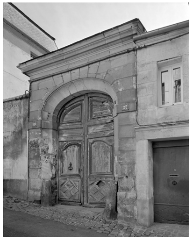
Le portail sur la rue du château. Phot. Thierry Lefébure IVR22_19940201131V
