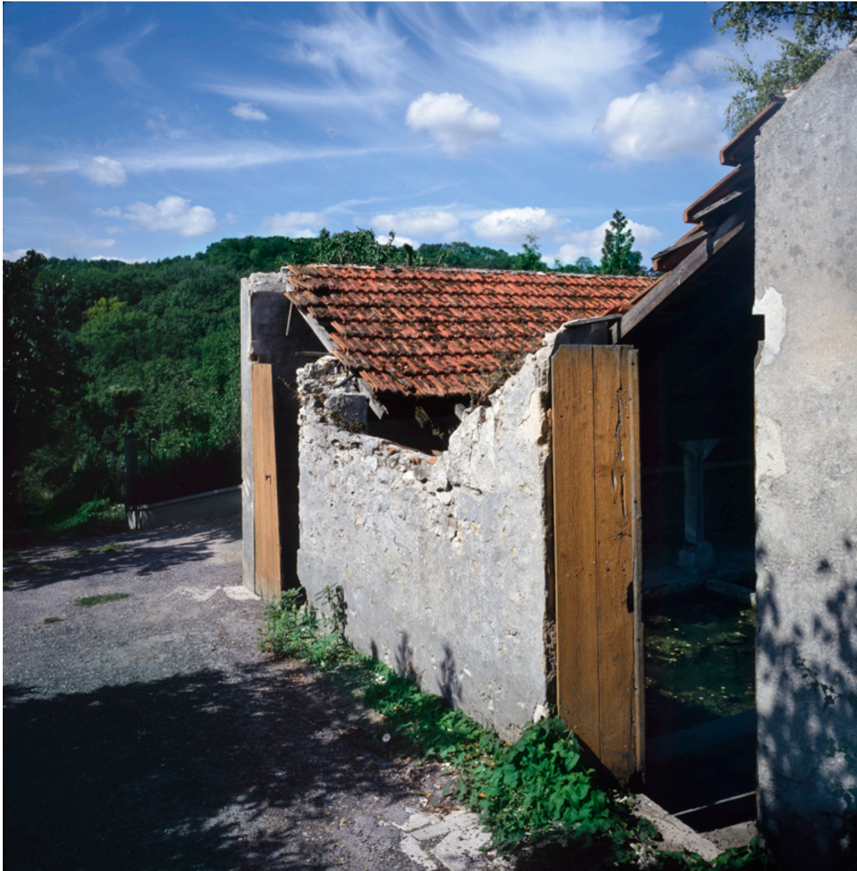
Lavoir : vue depuis la rue.
