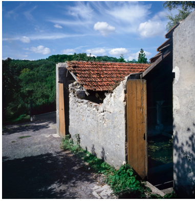
Lavoir : vue depuis la rue. Phot. Thierry Lefébure IVR22_19930200953VA
