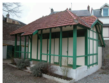
Les vestiaires, vue de trois-quarts.
