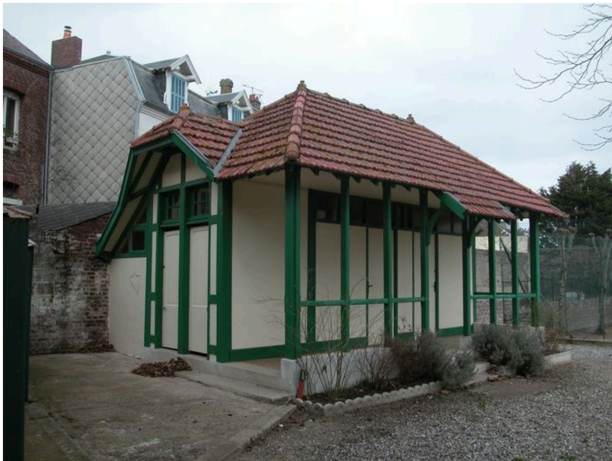
Les vestiaires, vue de trois-quarts.
