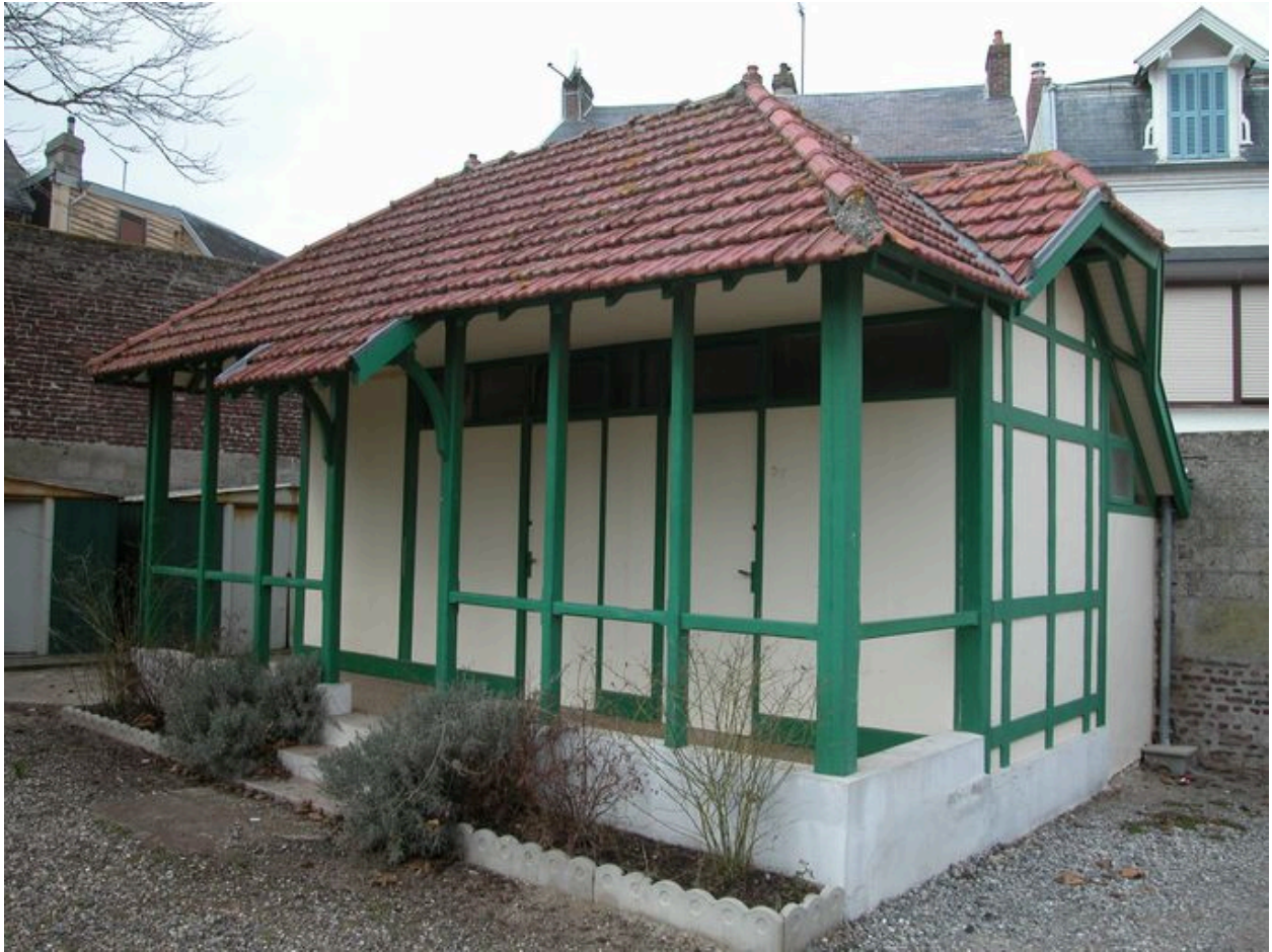
Les vestiaires, vue de trois-quarts.
