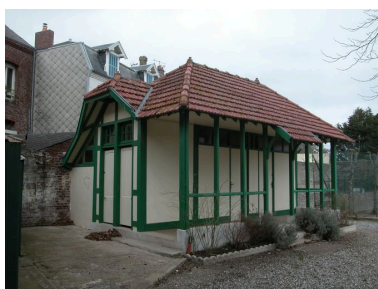
Les vestiaires, vue de trois-quarts.
