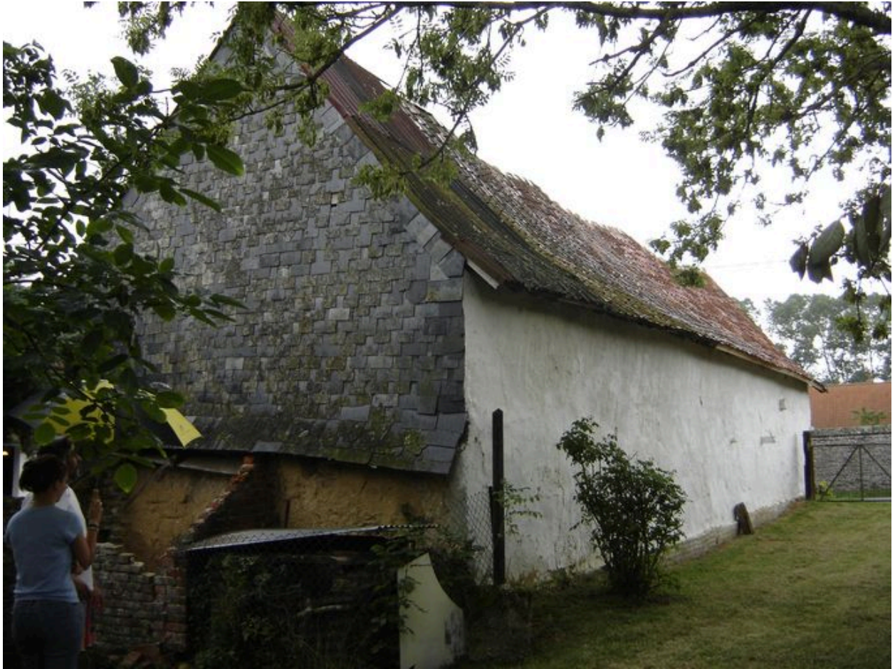
Vue postérieure du bâtiment.
