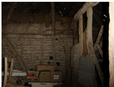
Vue intérieure de la grange. Phot. Inès Guérin IVR22_20068005096NUCA
