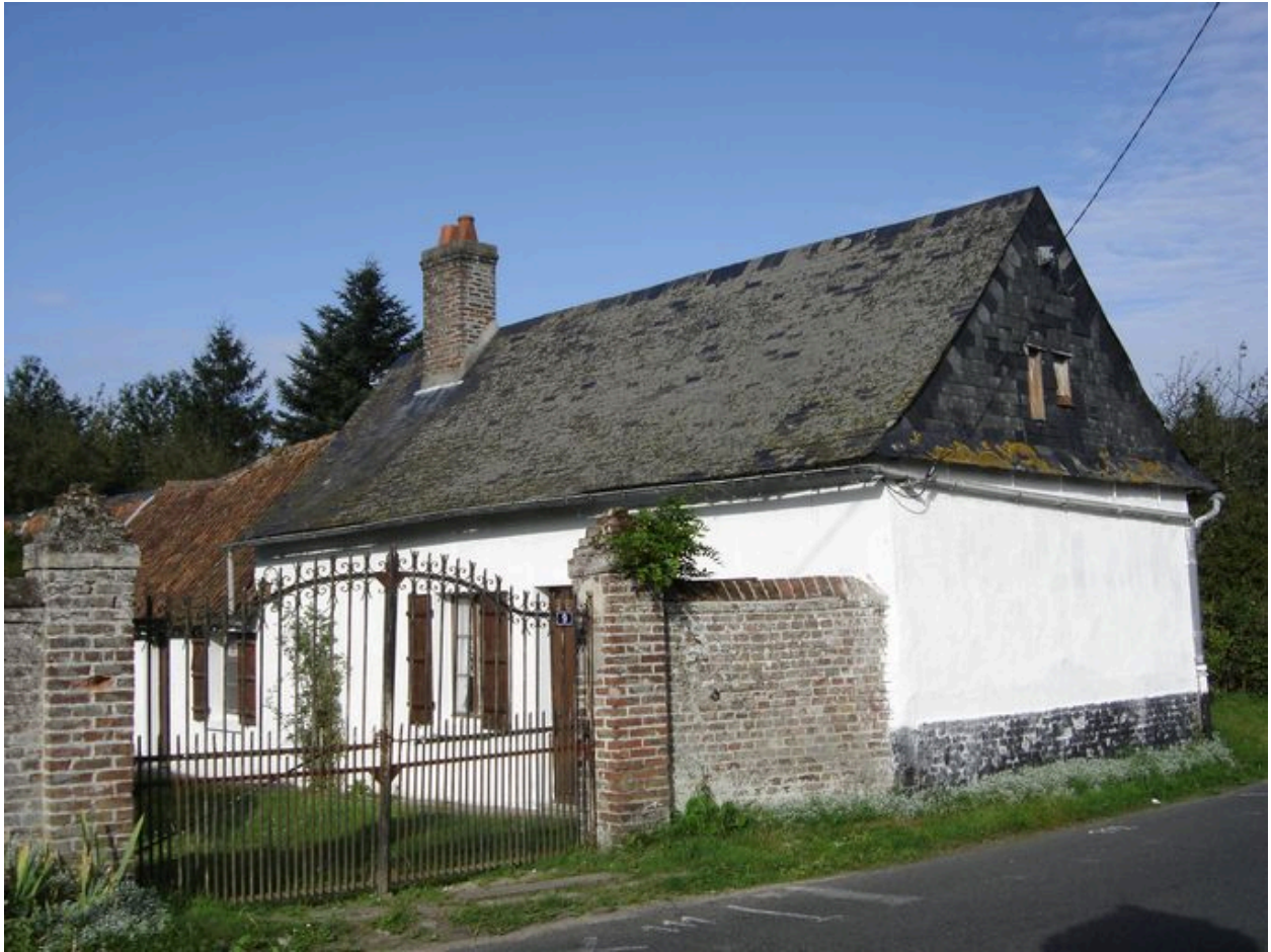
Vue du logis sur rue.
