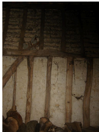
Autre vue intérieure de la grange : le mur inférieur est hourdis au torchis des deux côtés, ce qui n'est pas le cas pour le surcroît. Phot. Inès Guérin IVR22_20068005097NUCA
