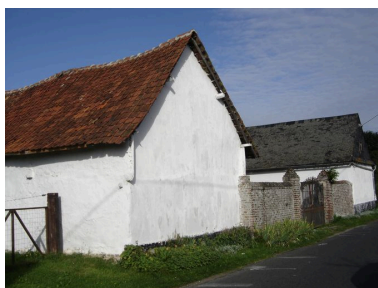
Vue générale de l'entrée de la ferme depuis la rue.
