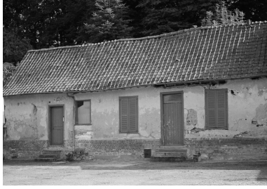
Logis en torchis, sur le côté sud de la cour. Phot. Judith Förstel IVR22_19988000888Z
