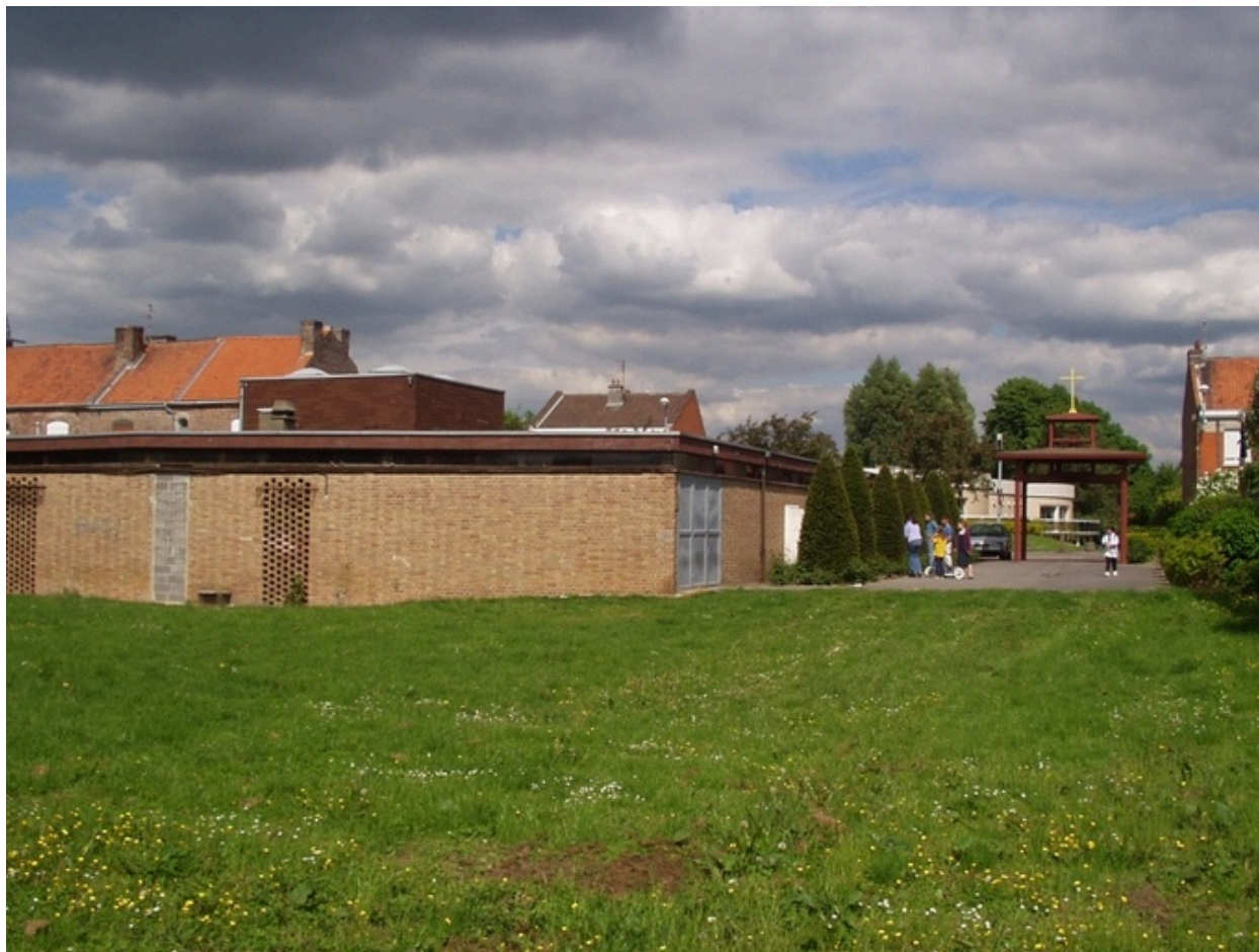
Vue de trois quart de l'église depuis le sud ouest.
