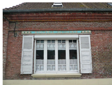
Détail de la baie large.
