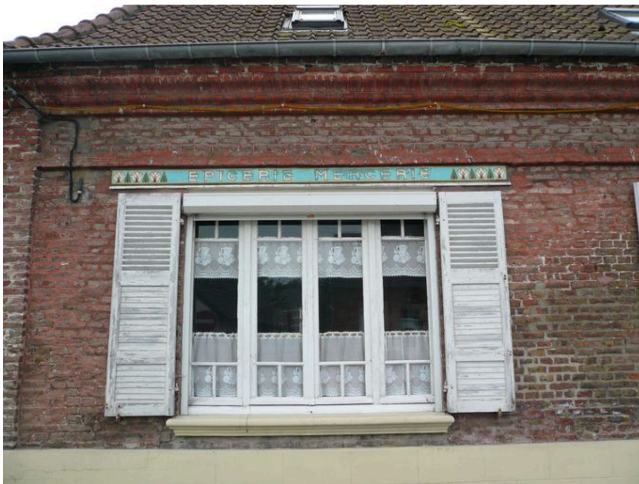
Détail de la baie large.
