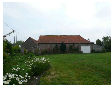
Vue latérale de la charretterie depuis la pâture bordant la propriété.
