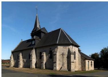
Vue extérieure depuis le sud-est. Phot. Marc Kérignard IVR32_20226000817NUCA
