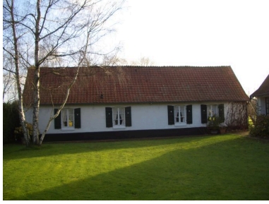
Vue générale. Phot. Inès Guérin IVR22_20078005078NUCA
