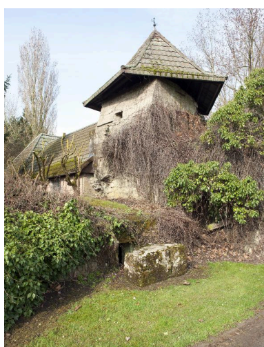
Vue générale vers le nord-ouest. A gauche de la tour, l'accès à la casemate à personnel avec son mur par-souffle Phot. Pierre Thibaut
