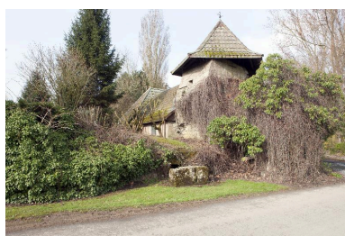
Vue générale vers le nord-ouest. En bas et à gauche de la tour, l'accès à la casemate à personnel. Phot. Pierre Thibaut IVR32_20165900555NUCA
