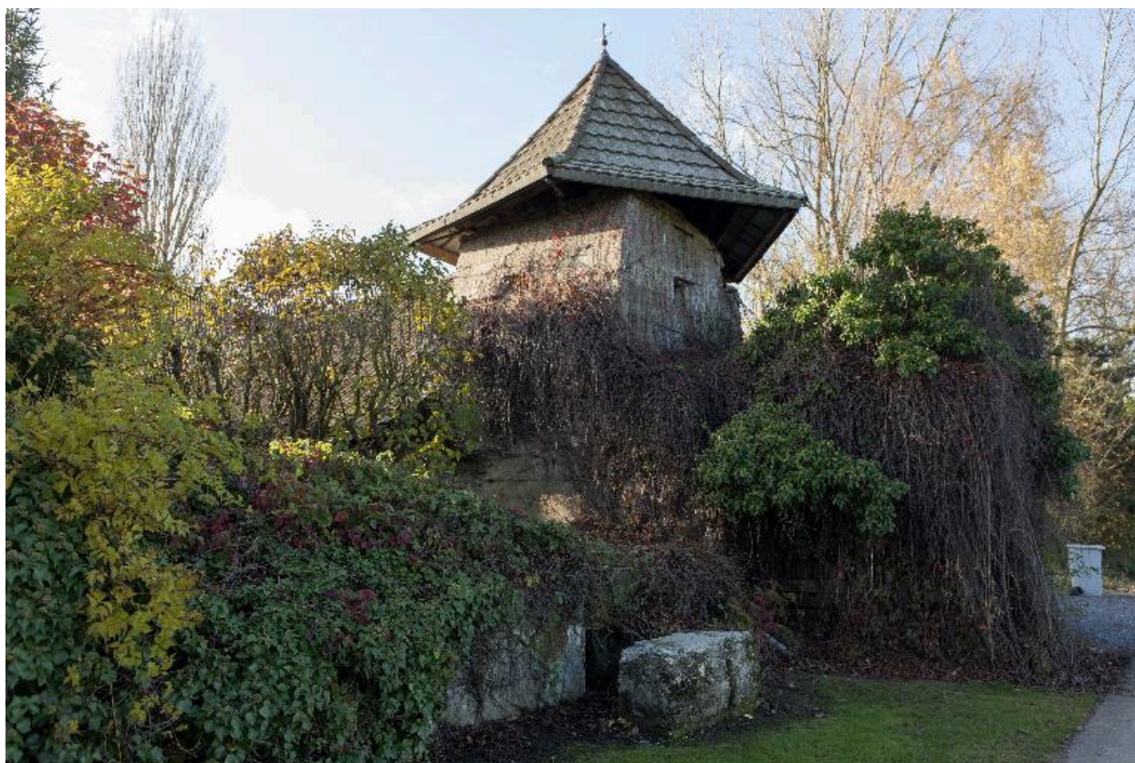
Vue générale, vers le nord-ouest
