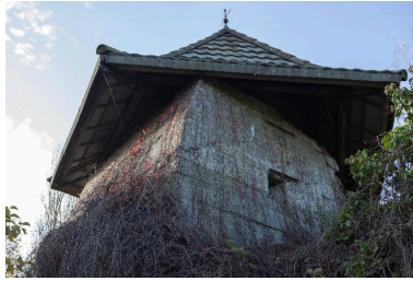
Sommet de l'observatoire Phot. Jean-Marc Ramette IVR32_20175901090NUCA
