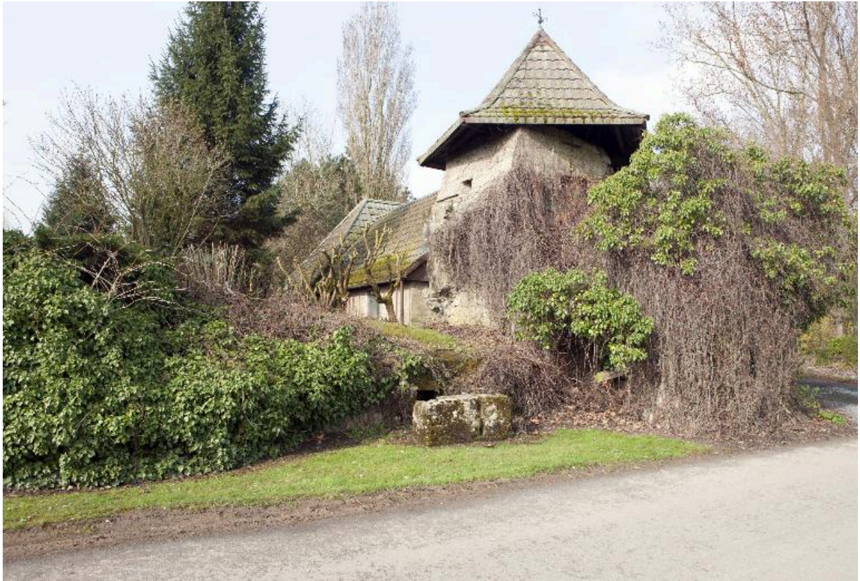
Vue générale vers le nord-ouest. En bas et à gauche de la tour, l'accès à la casemate à personnel.
