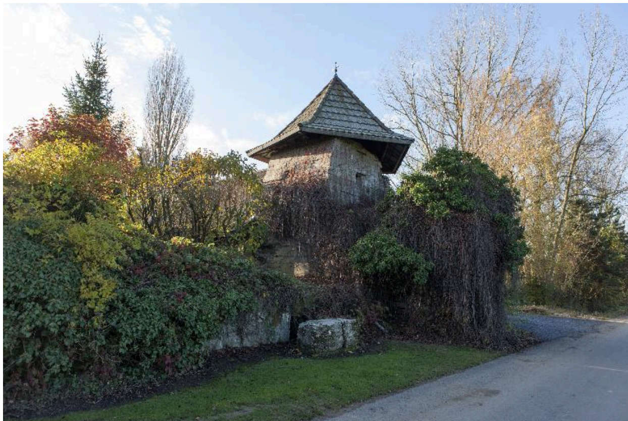
Vue générale vers le nord-ouest
