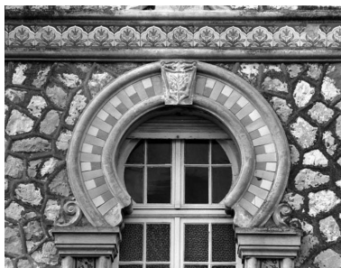
Détail de fenêtre au rez-de- chaussée de la façade latérale droite. Phot. Philippe Caudroit IVR31_19816203748X
